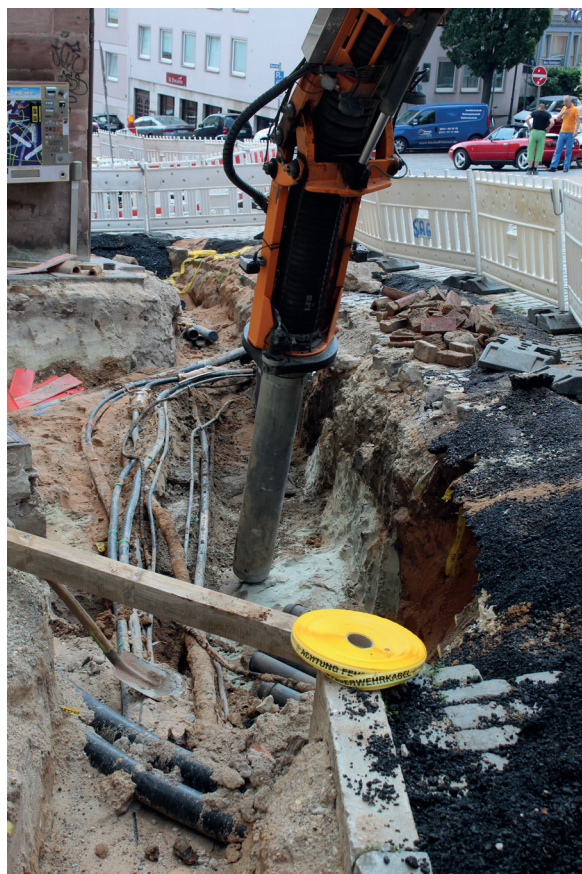
Abb. 2 Saugbagger im Einsatz auf einer Kabeltrassengrabung im Sommer 2020, Nürnberg. Dieser Abschnitt war bereits vollständig durch Leitungen belegt und mit Sand aufgefüllt worden. Aus archäologischer Perspektive spricht in diesem Fall nichts gegen den Einsatz dieser Maschine. (Foto: B. Srock M.A., Kreuzschnitt GmbH).
