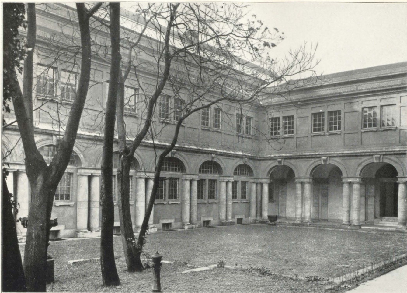
Bestelmeyerscher Neubau. Ansicht nach Norden gegen das ehemals Beckh'sche Wohngebäude.
