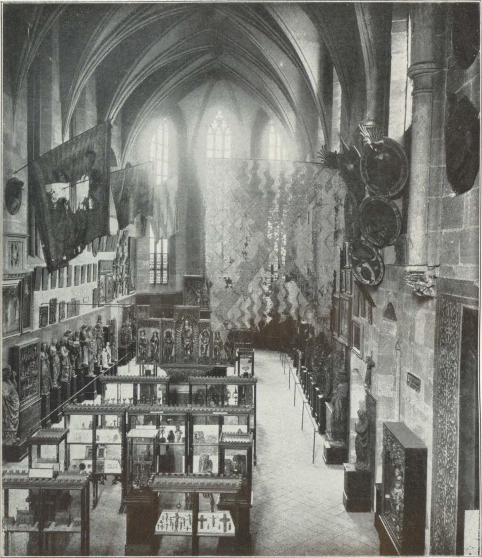
Die Karthäuserklosterkirche vor Inangriffnahme des Neubaues.
