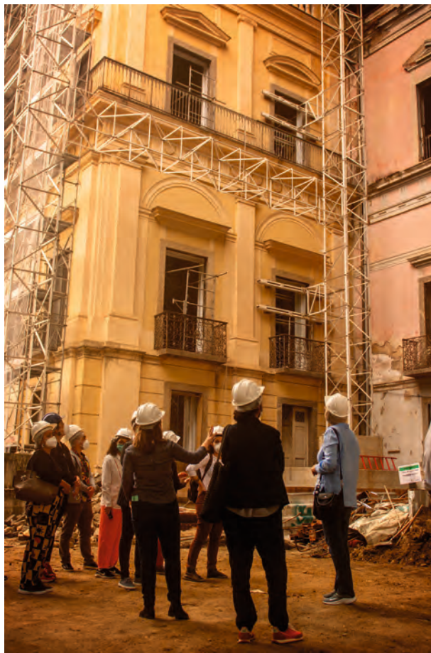
Abb. 1 Besuch der Baustelle des Museu Nacional in Rio de Janeiro im Rahmen der Museumskonferenz Foto: Ira Barillo © Goethe-Institut
