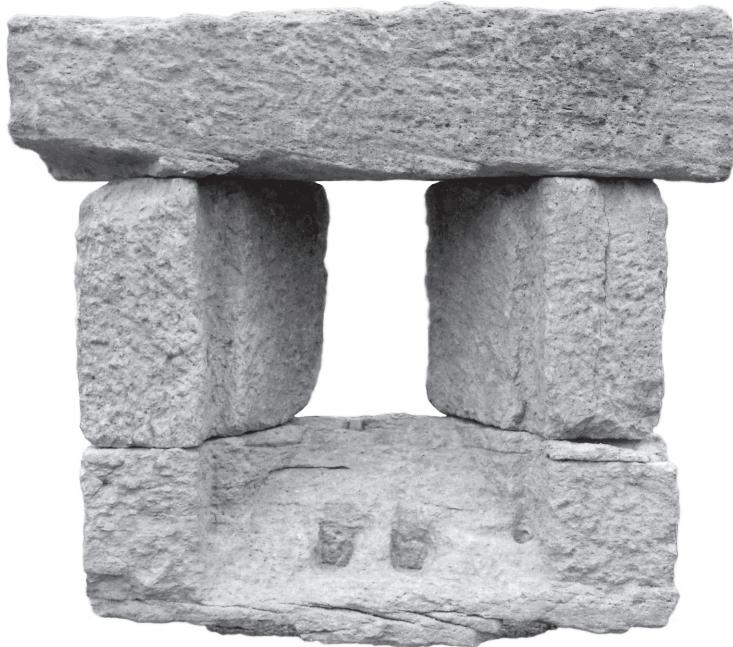
Abb. 31. Innenansicht der Fensterelemente aus Muschelkalksandstein mit den Vorrichtungen einer doppelten Reihe von Gitterstäben und der Verriegelung eines Fensterladens. Öffnung auf der Außenseite 53 × 21 cm. Insula 7, vgl. Abb. 30 (MOREL 1991, 129 Abb. 6).
