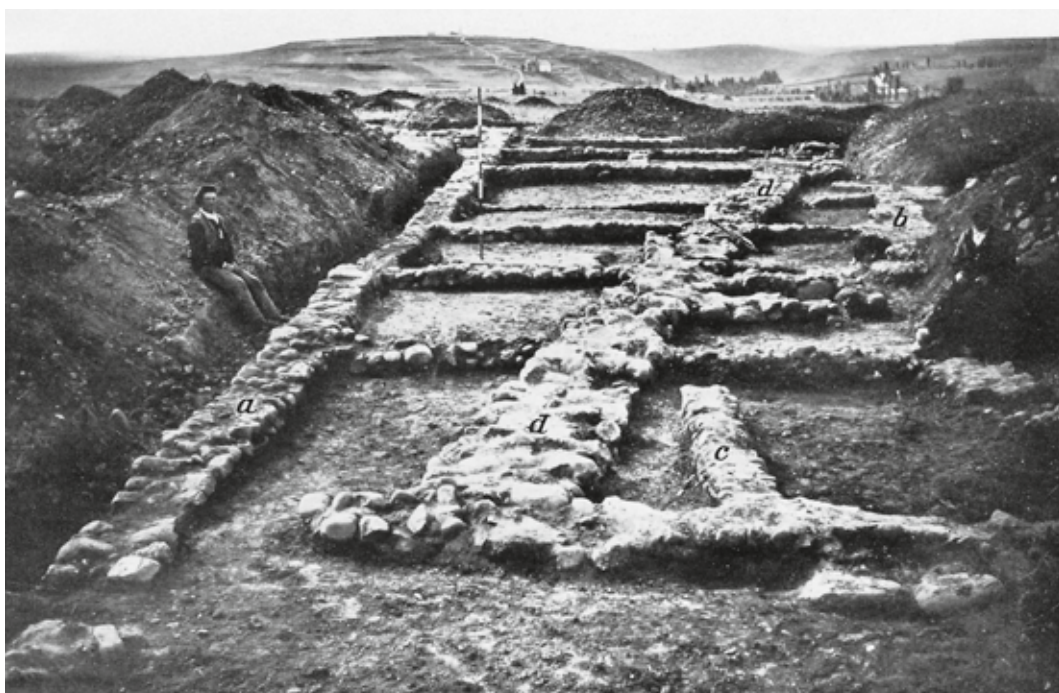
Abb. 10. Ausgrabungen 1908 im römischen Lager von Castillejo. Die verschiedenen Bauperioden sind gut zu erkennen. Im Hintergrund der Siedlungshügel des Oppidums.
