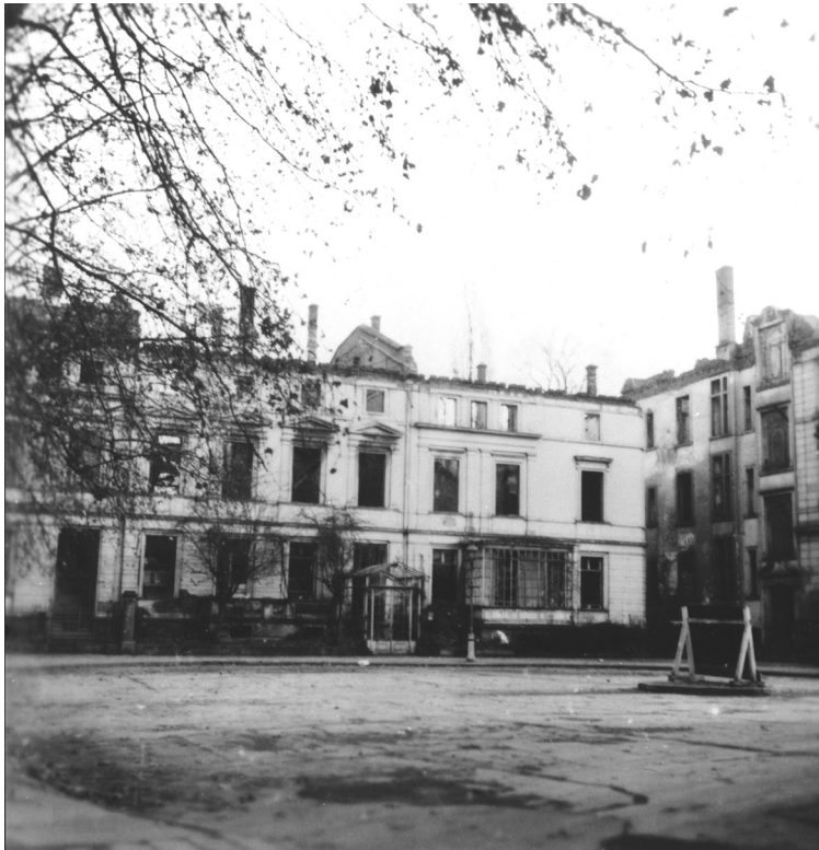
Abb. 34. Das ausgebrannte Institutsgebäude der RGK, 1944 (Archiv RGK).
