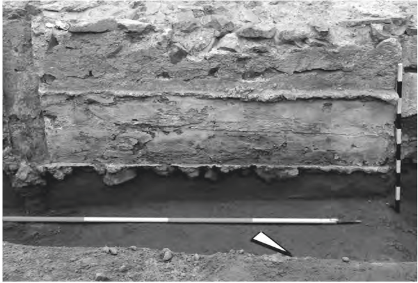
4 Xanten, Colonia Ulpia Traiana. Monumentalgebäude Insula 18. Abdrücke der Holzverschalung auf der Frontseite der Mauer in Schnitt 2006/08.
