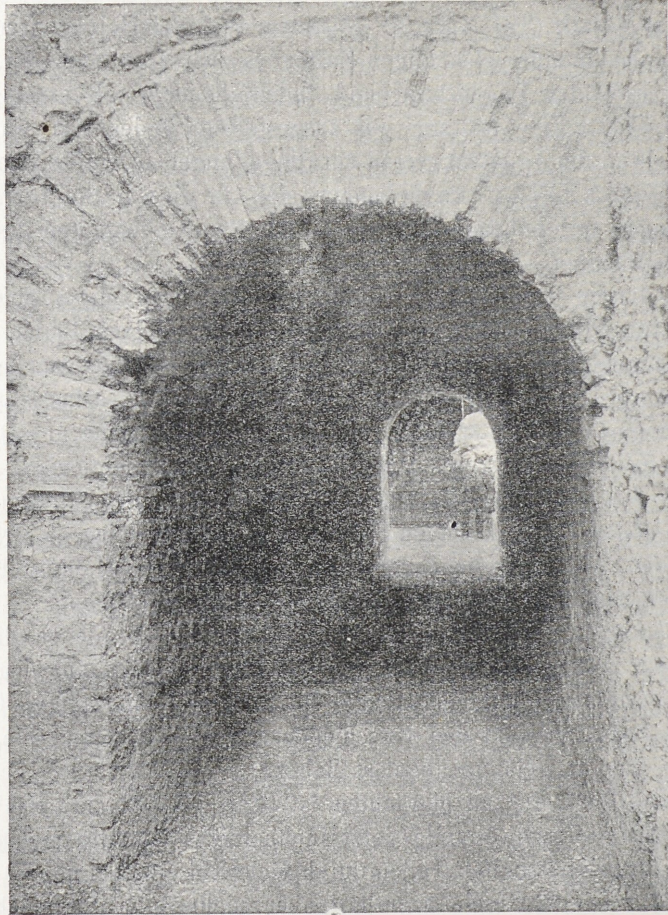
Abb. 2. Kellergang unter Raum 19', der Apsis von Saal II'.
