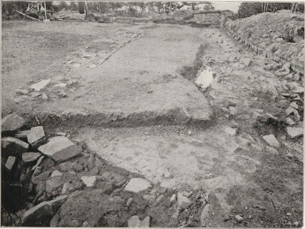
1. Ältere Mauer und Anschüttung in A.
