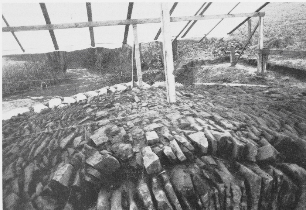
70 Lindlar-Berg, freigelegte Fahrbahn der Steinbrücke.
