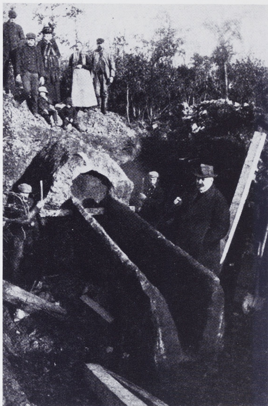
1 Euskirchen-Kreuzweingarten. Sintergewinnung um die Jahrhundertwende. Zum Abbau wird die Wasserrinne um die Sinterschicht abgebrochen.
