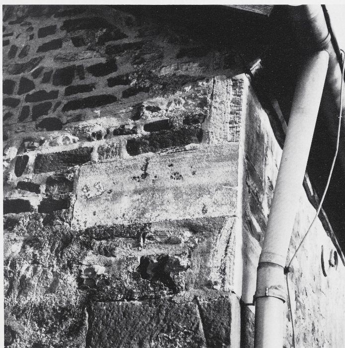
17 Swisttal-Odendorf, St. Peter und Paul. Eckquadersteine der Südwestecke aus Kalksinter.
