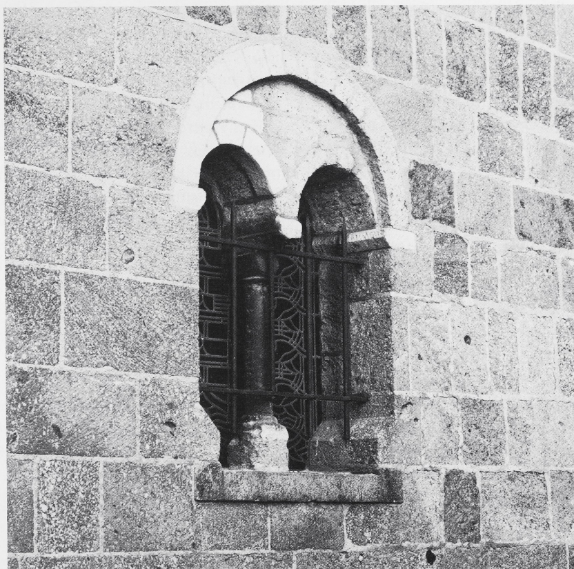
25 Siegburg, St. Servatius. Fenster der nördlichen Seitenhalle mit Basis, Säulenschaft, Kapitell und Sattelkämpfer aus Kalksinter (übertüncht).
