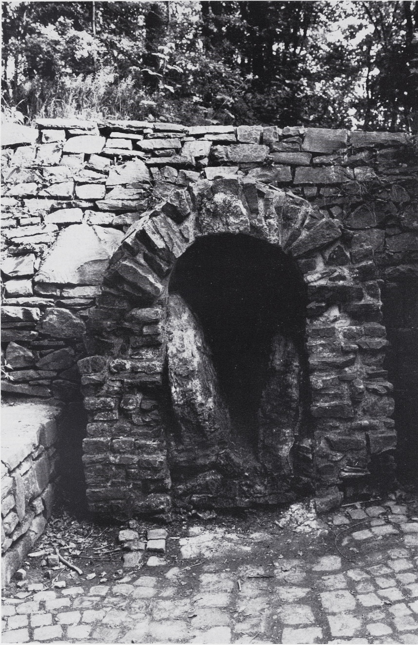
2 Euskirchen-Kreuzweingarten. Kalksinterschichten in der römischen Eifelwasserleitung.
