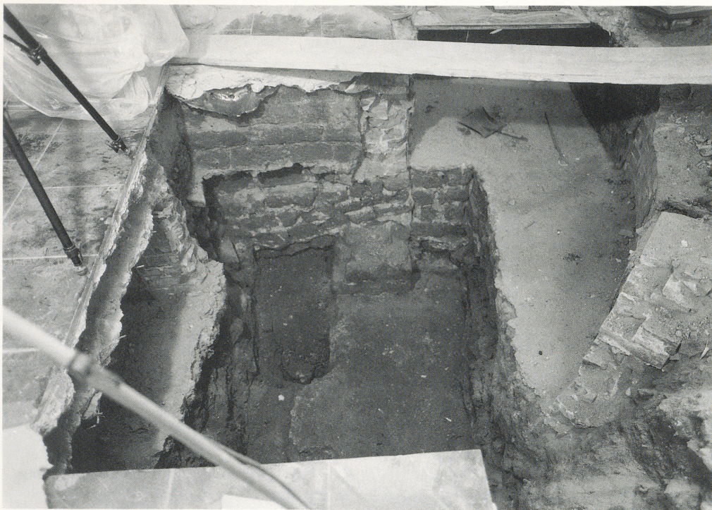
20 St. Martinuskirche in Bedburg-Hau-Qualburg, Tufffundament.
