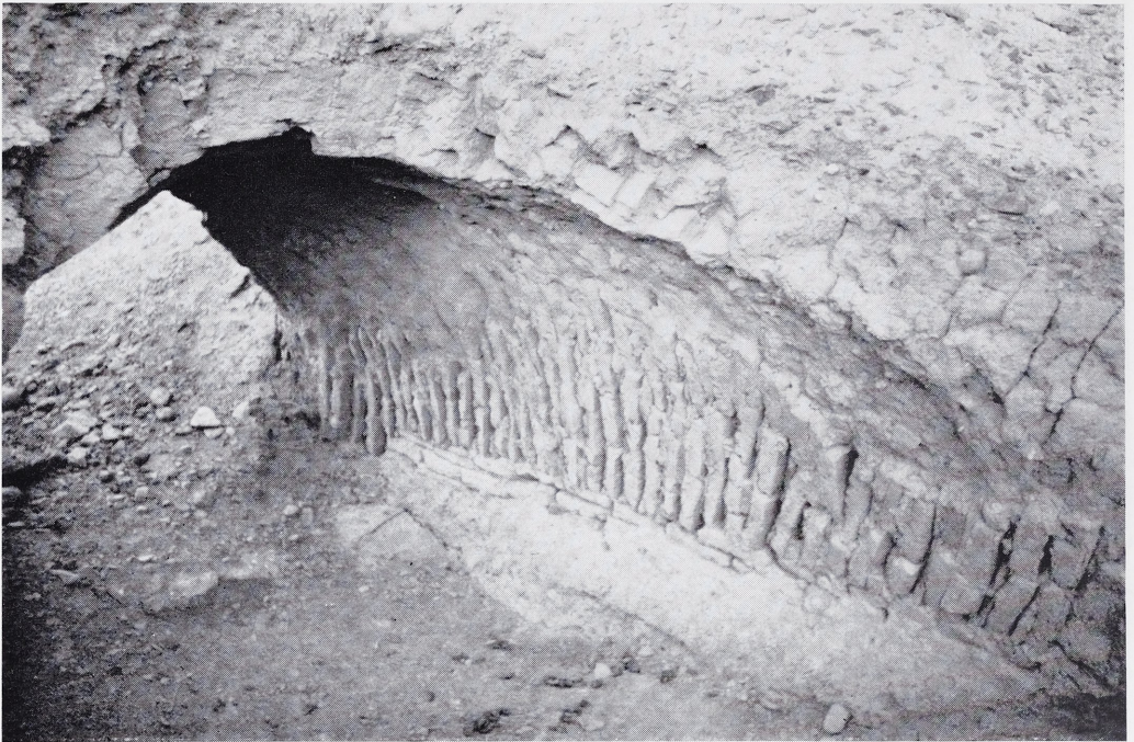
11 Reste von Lehmziegelgewölben im Unterteil des Tepe Azam Qala.
