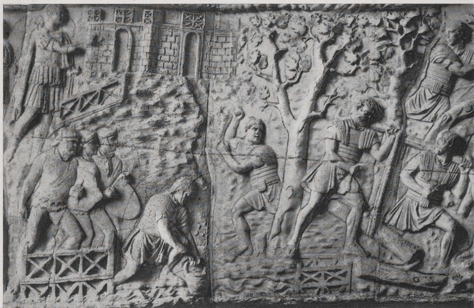
Abb. 2. Pfahljochbrücken mit zwei (links) und einem (rechts) Mitteljoch (Trajanssäule Bild XIV/XV).
