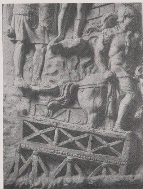
Abb. 3. Brückenstummel mit vier Mitteljochen (Trajanssäule Bild XXI).
