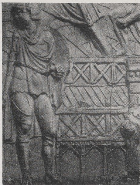
Abb. 1. Pfahljochbrücke aus doppelten Sprengwerken (Trajanssäule Bild XI/XII).
