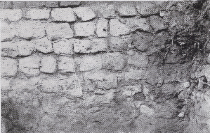
Abb. 2. Baugrundriß C, Teilansicht der Tuffsteinmauer (1) auf der Südseite der Hauptburg. Auf der Mauer unten Reste eines Putzes aus Kalkmörtel.
