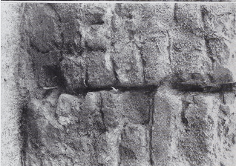
Abb. 2 u. 3. Grundriß C. Seitenansicht von 2 Baufugen; innen jeweils die wenig tiefer reichenden Verbindungsmauern, außen die Bauecken. Aufgenommen an der Westseite der Hauptburg.
