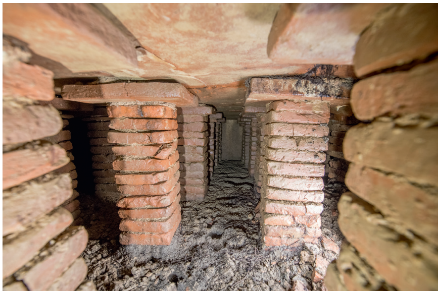
Abbildung 2 Die archäologische Begleitung von Bauarbeiten für eine neue Wasserleitung in Bonn-Friesdorf überraschte mit einer auf rund 36 Quadratmeter fast gänzlich in situ erhaltenen Hypokaustanlage.
