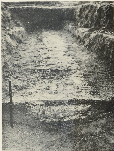
Abb. 1. Ostwand der Eingangshalle zum Valetudinarium (Fundamentunterlage).
