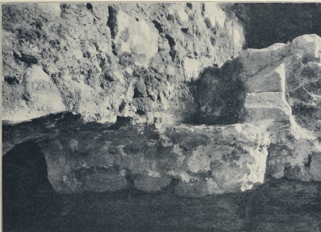
Kamin-Fundament und -Pfeiler des Gebäudes Y, nach Nord.
