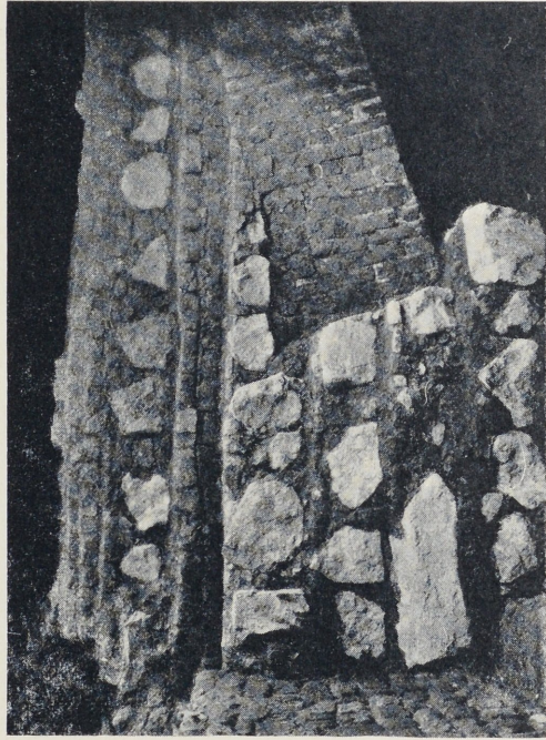
e) Gotischer Fundamentbogen der Westwand, Innenseite, der Barbarakapelle.
