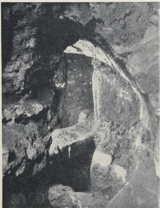
d) Gewölbe K unter der Kryptanordwand, nach Norden.
