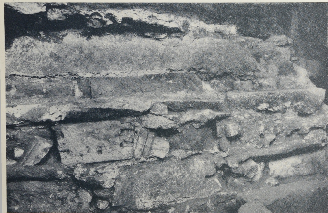
Gebäude D. Fundament und aufgehende Innenwand der Südwestmauer.
