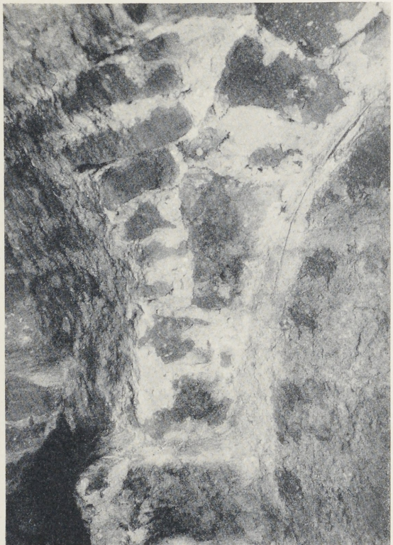
b) Cassiusgruft, Verzahnung der nördlichen Bogennische mit der späteren Längstonne.
