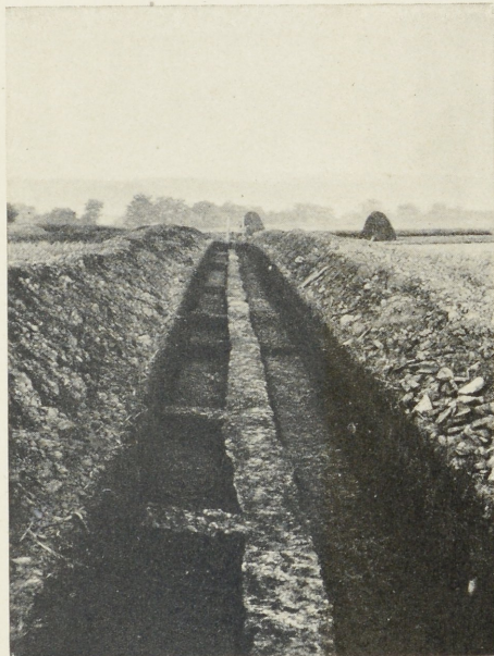
Abb. 1. Rückwand der Läden nördlich der via principalis (Fundamentunterlage aus Ton.)
