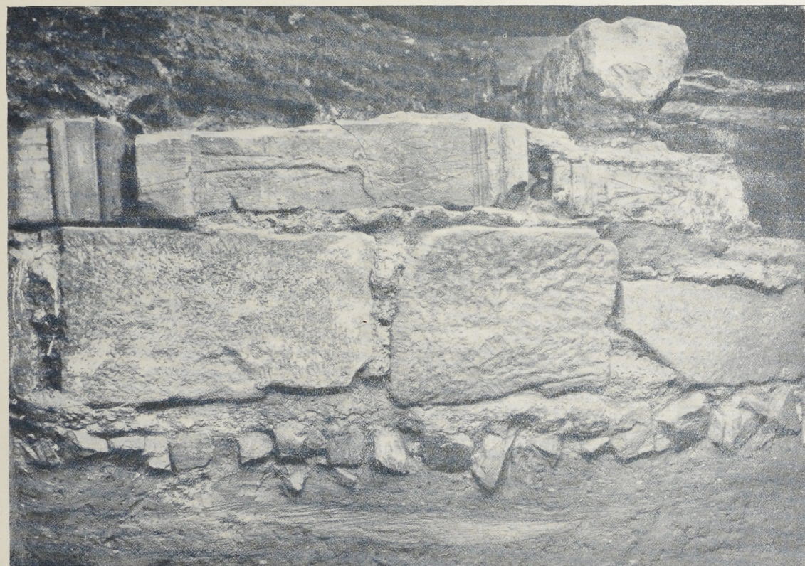
Gebäude D. Stickung und Fundament der Nordostmauer.
