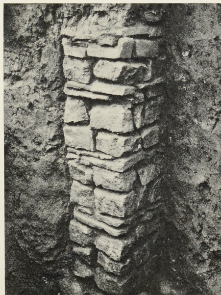
Abb. 4. Fundamentpfeiler im Ostflügel des Valetudinarium.
