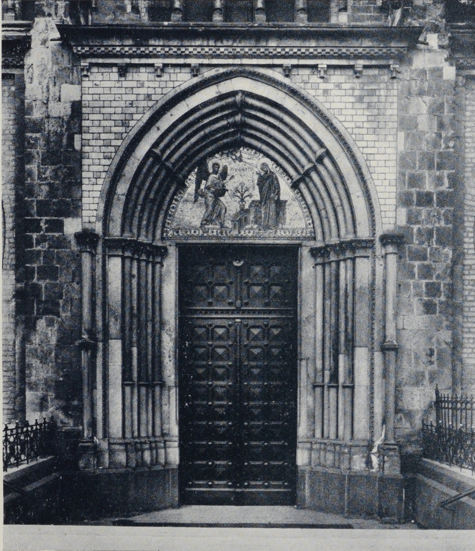
Nordportal des Bonner Münsters (Zustand 1931).
