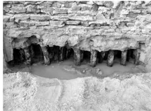
3 Thermen Insula 10, Basilica thermarum. Eichenpfahlrost unter dem nordwestlichen Fundament.
