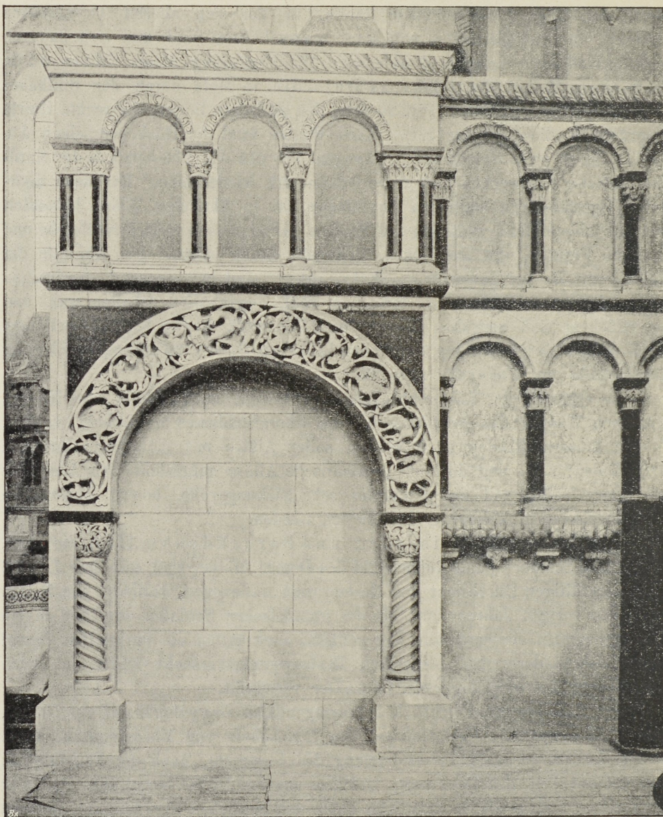
Fig. 20. Trier, Dom. Südlicher Lettnerbogen nach der Wiederherstellung.
