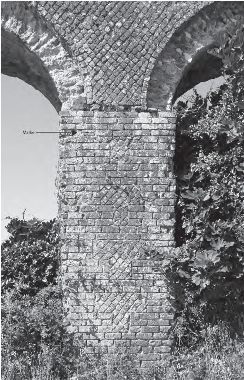
Abb. 10 (oben) Minturnae, Aquädukt. In Pfeiler 19 sind vier Retikulatfelder übereinander angebracht. Im oberen Feld ist der Querbalken des T ab der Höhenlage der Ziegelmarke nur mit einer Steinzeile ausgeführt. Hier markiert die Ziegelmarke die Änderung der Bauausführung besonders deutlich.
