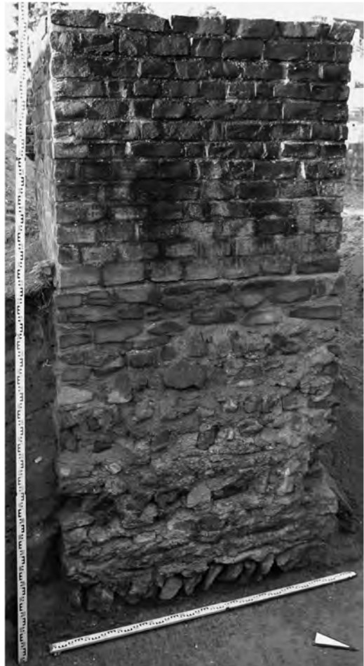
Abb. 7 Insula 40. Lediglich der unterste Teil des Pfeilers 65 besteht noch aus antikem Mauerwerk, darüber befinden sich Aufmauerungen aus den dreißiger (?) und siebziger Jahren.
