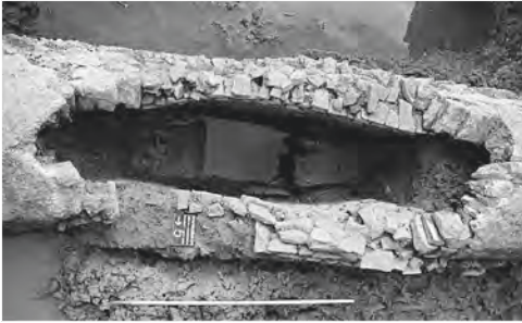
Tosbecken der Eifelwasserleitung an einer Baulosgrenze bei Mechernich-Lessenich.
