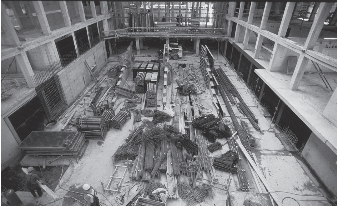
3 Großbaustelle Rheinisches Landesmuseum Bonn: Materiallager im ›Schell-Bau« an der Stelle von Foyer und Treppenhaus, Blickrichtung zu Colmantstraße.
