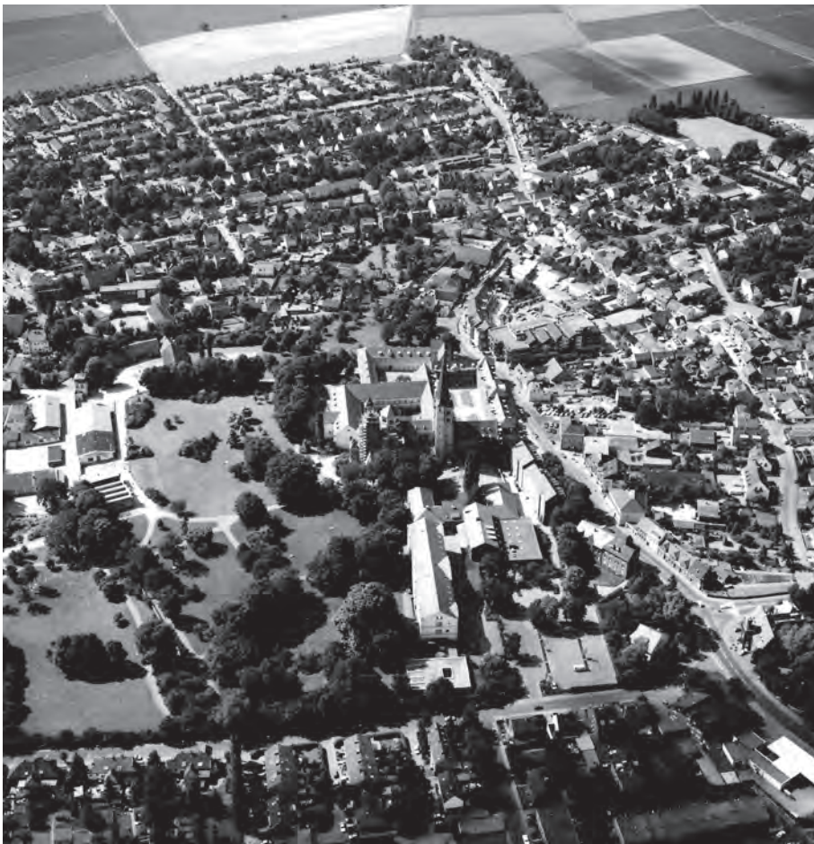
Abb. 4 Luftbild von Brauweiler, 18. März 1988 (Blick nach Süden).
