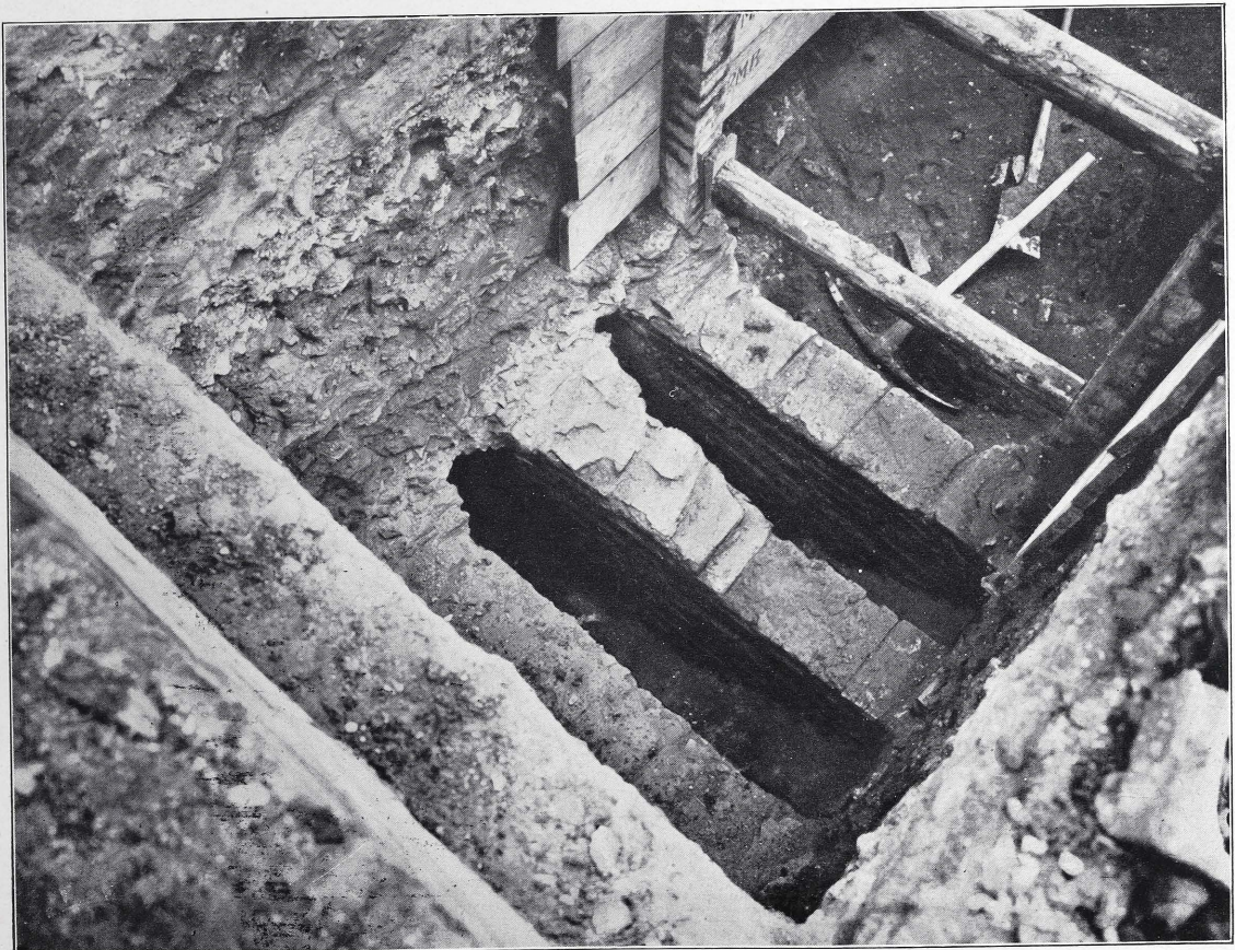
2. Züge im Feuerraum. Ziegelofen I in Bonn, Universitätsneubau.
