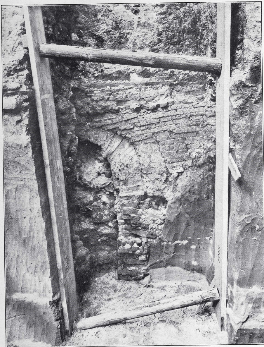
Teil des Schürkanals von Ziegelofen I in Bonn; von S.-W. gesehen.
