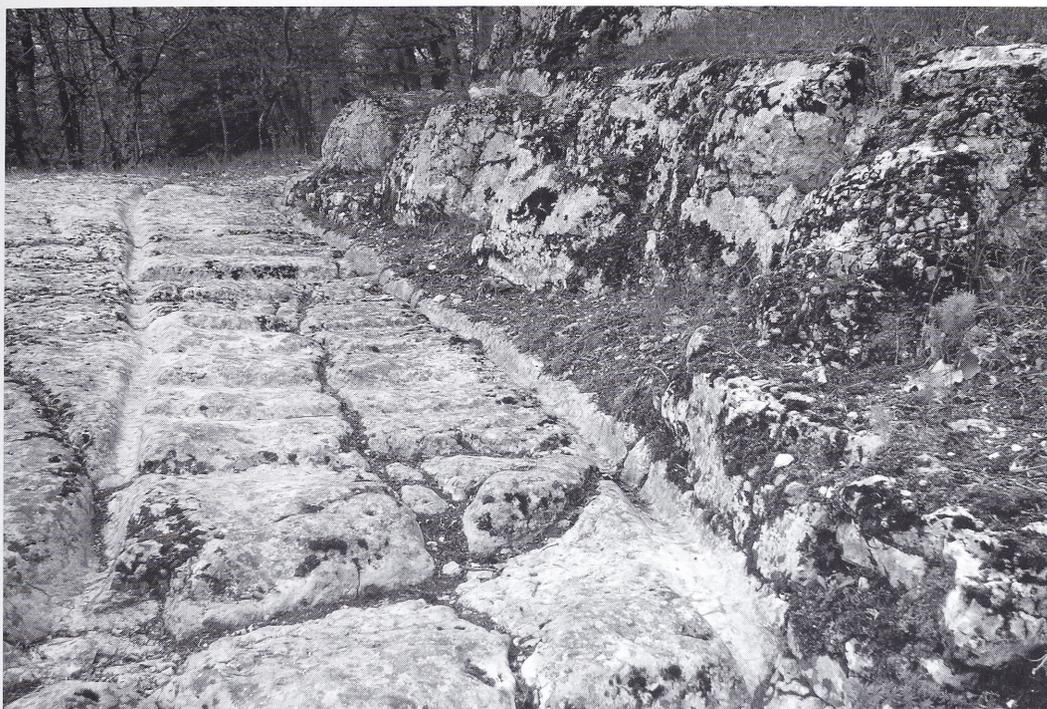
4 Wegoberfläche aus anstehendem Fels. Die Gehfläche zwischen dem Rillenpaar ist mit Trittstufen ausgestattet (Standort: 905 m ü. M.).
