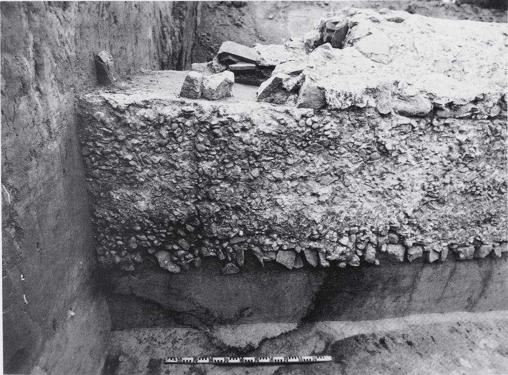
28 Hürth-Hermülheim (55.16). Unter einer Nahtstelle im Opus-Caementicium-Körper der Leitung deutliche Ausfällung von Mangan und Eisenoxiden.
