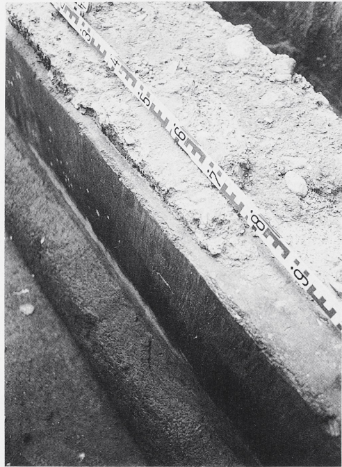
24–25 Bornheim-Walberberg (49.9). Die in der Baustelle Hauptstraße 79 freigelegte Rinne der Eifelwasserleitung. Der Ausgrabungsbefund zeigt den Betonkern der rechten Leitungswange mit sauberem Opus-Signinum-Verputz auf der Innenseite; in der unteren Ecke kräftiger Viertelrundstab.
