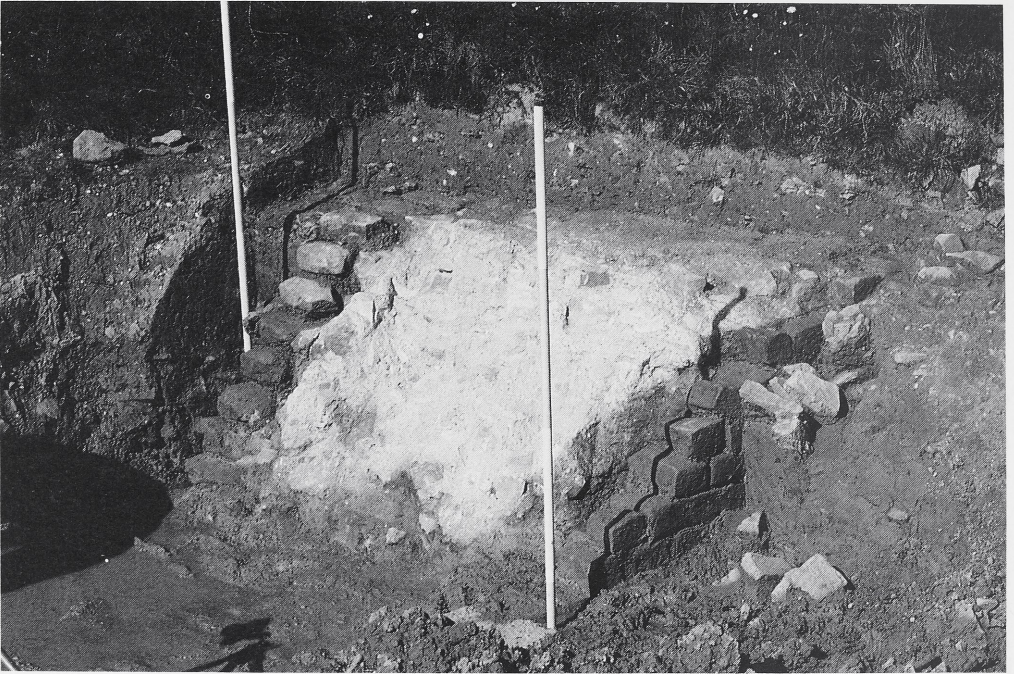
10 Mechernich-Lessenich (24.5). Substruktion der Aquäduktbrücke über den Kühlbach.
