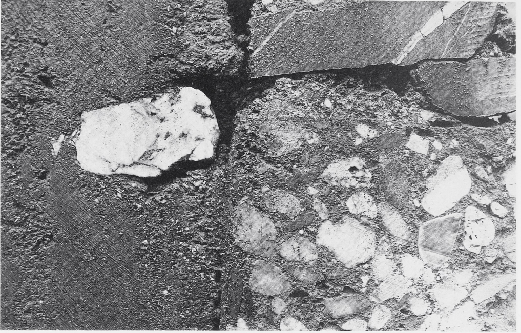
32 Hürth-Hermülheim (55.16). Schnitt durch das Opus caementicium mit oberem Ende der rechten Wange und Ansatz des Gewölbes. Die Opus-Signum-Schicht bedeckt die Innenseite der Wange und zieht auch unterhalb des Gewölbeansatzes noch zur Hälfte der Wangenbreite ein.
