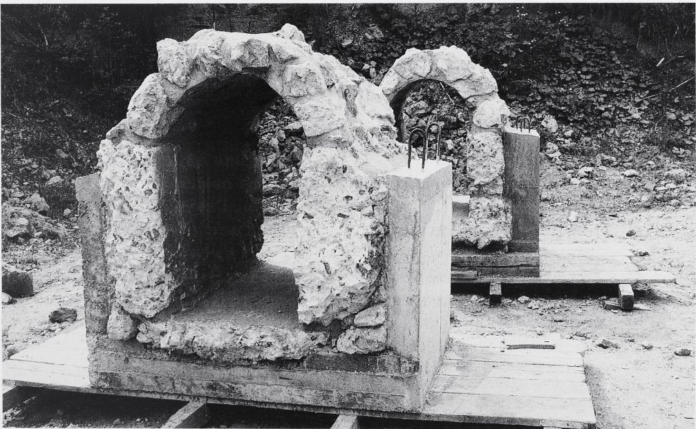
5 Kall-Sötenich, Zementwerk (11.3). Aus den erhaltenen Resten der Wasserleitung zusammengebaute Anschauungsstücke.
