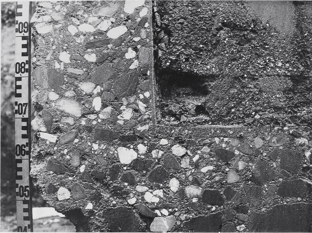
31 Hürth-Hermülheim (55.16). Schnitt durch das Opus caementicium mit linker unterer Ecke des Baukörpers. Deutlich sichtbar die als Zuschlagmaterial verwendeten Kiesel, der Innenverputz aus Opus signinum und eine dünne Kalksinterablagerung unter der nachrömischen Verfüllung.
