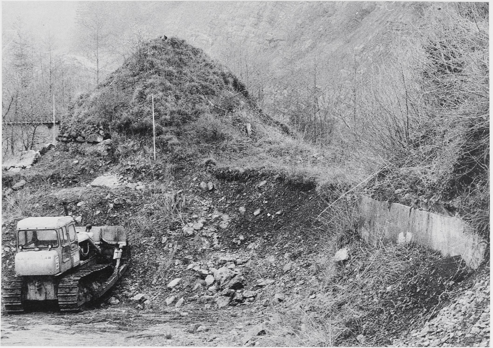
3 Kall-Sötenich, Zementwerk (11.3). Rechts im Hang und im Erdhügel Reste der Eifelwasserleitung in situ.
