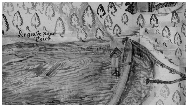
Abb. 6 (rechts) Ausschnitt aus dem Riss des Bockswieser Zugs von Daniel Flach, 1674: Der damals neue Teich (heute Oberer Grumbacher Teich) mit Damm, Flutgraben und Striegelhaus.
