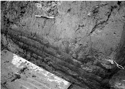
Abb. 3 Blankenheim. Der Schnitt durch das teichseitige Ende des Rasenhauptes zeigt mehrere Sodenlagen und den stufenartigen Anstieg des Untergrundes (links).
