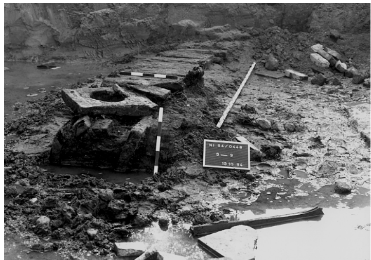
Abb. 12 Brüggen. Aus Bohlen zusammengesetzte Wasserleitung im Stadtgraben.
