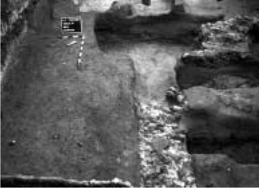
6 Xanten/Kreis Wesel, Colonia Ulpia Traiana. ›Hafentempel‹ Insula 37, Fundamentstieck von dem Bau Y, im Hintergrund gestört durch die Ausbruchgrube eines Porticusfundamentes des Temenos.
