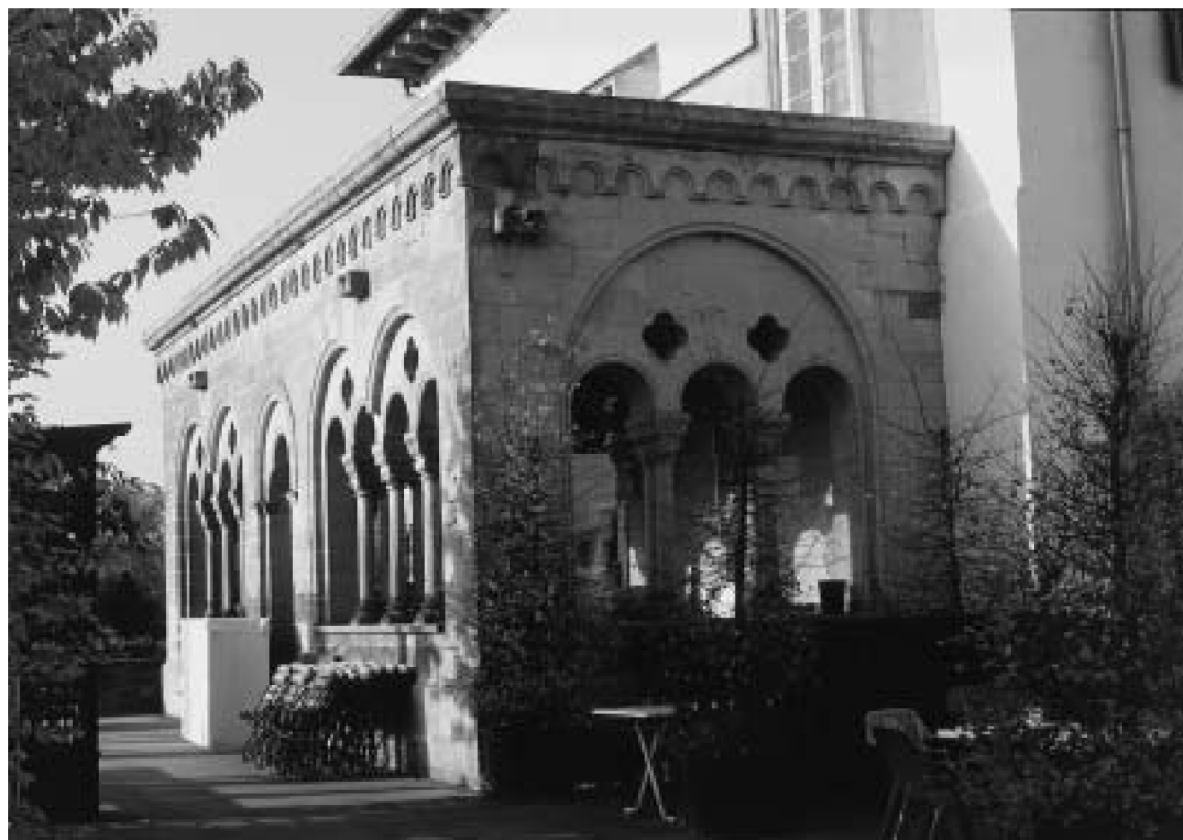
14 Bad Homburg v. d. H., Wirtschaftsanbau am Schloss mit wiederverwendeten Basen und Kapitellen aus der Abteikirche von Brauweiler.
