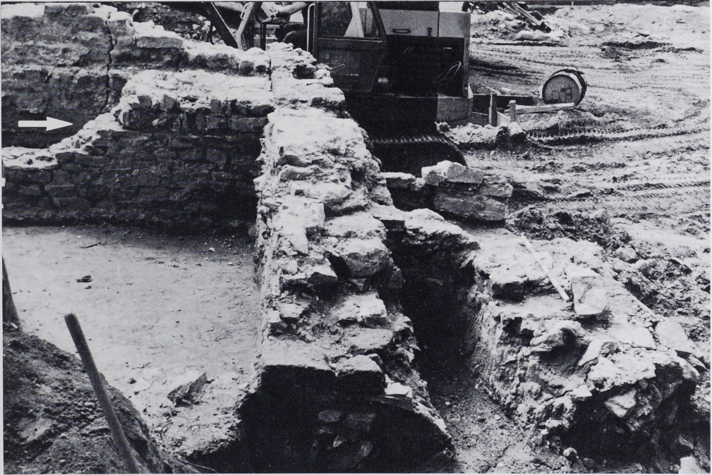
7 Nördliche Begrenzung des Mosaikraumes (Mitte); im Hintergrund frühcoloniazeitliche Mauer 730 und westliche Begrenzung des Mosaikraumes; Pfeil markiert die horizontale Baufuge in Mauer 730.
