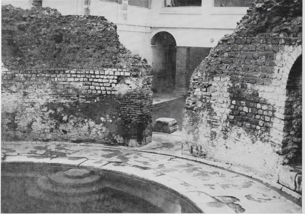
7 Aqueae Flavianae, Thermalbad. Rundbecken mit konzentrischen Segmentstufen
