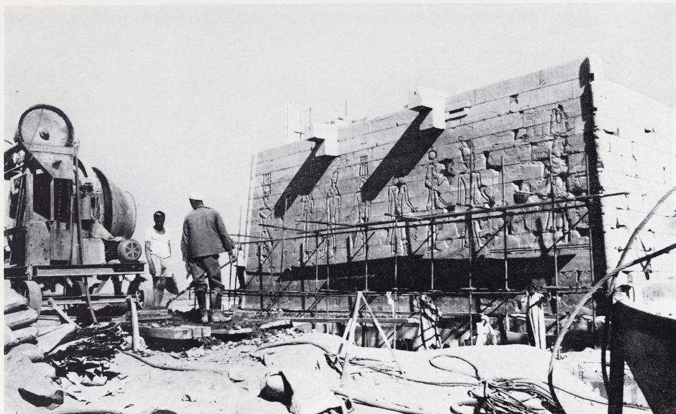
6. Westliche Außenseite des Sanktuars während des Wiederaufbaus. Die Schichthöhen: 50–53 cm (etwa eine ägyptische Elle). Oben zwei Wasserspeier. Die großfigurige Szene stellt rechts und links außen den Herrscher Ägyptens dar, dazwischen, von links, Isis, Horus, Mandulis, Horus, Isis und Osiris.
