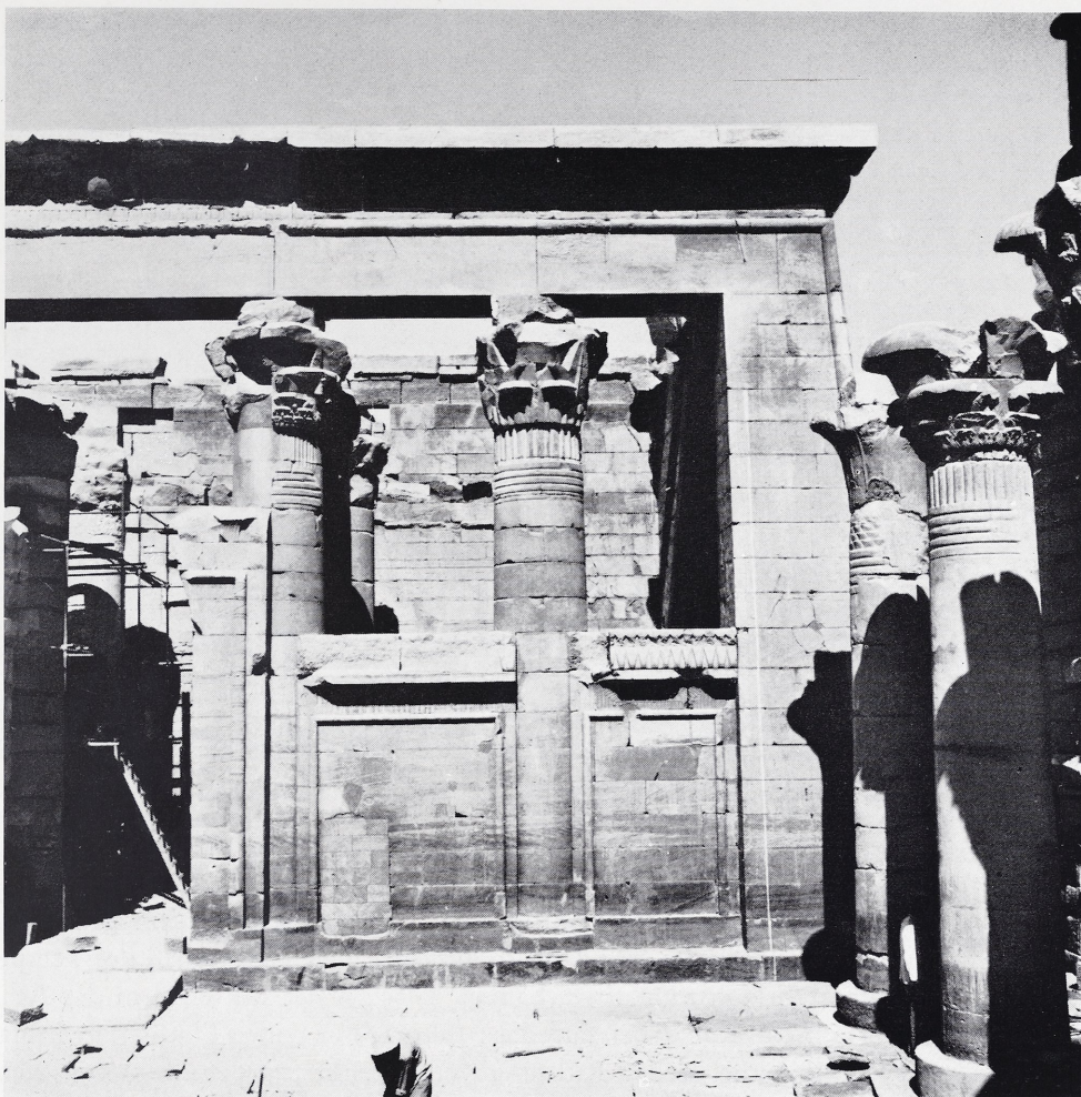
8 Hypostyle-Halle des Tempels von Kalabsha, nördlicher Teil, während des Wiederaufbaus.
