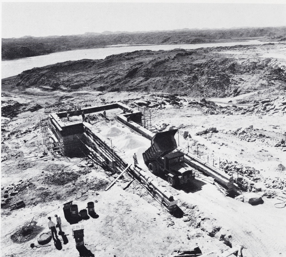
7 Die wiederaufgebaute Kaianlage. Blick von der Höhe des Pylons nach Osten.
