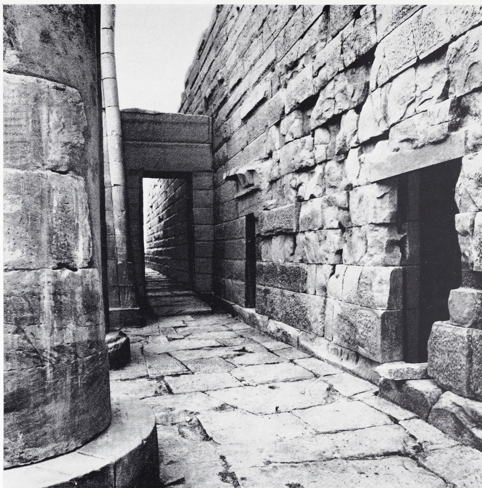
10 Blick in den nördlichen Umgang des Tempels vom Säulenhof aus, nach dem Wiederaufbau. Die beiden Tore führen zu Kammern in der inneren Umschließungsmauer.
