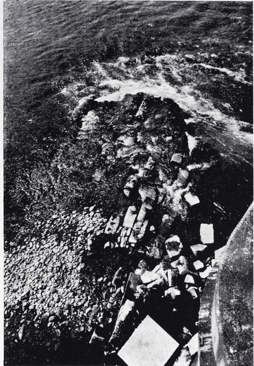
8 Pfeiler 4. Fundamentquaderlage mit Resten der 'Pfahlpundung'. Im Vordergrund rechts moderne Quaderanschüttung.
