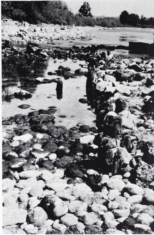
3 Römische Ennsbrücke. Ansicht von Süden auf die 'Pfahlspundung' an der Ostseite von Pfeiler 1.
