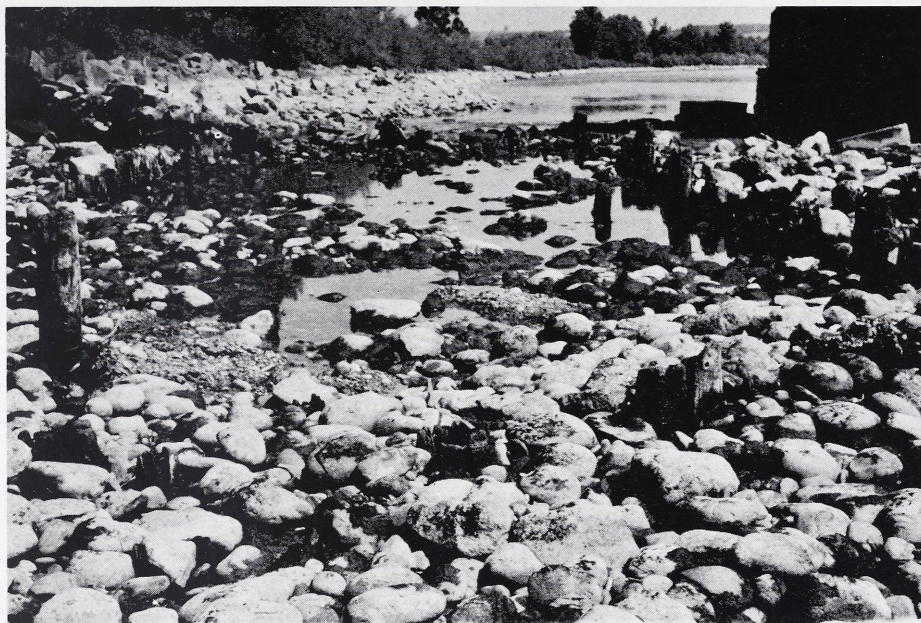
4 Römische Ennsbrücke. Pfeiler 1.
