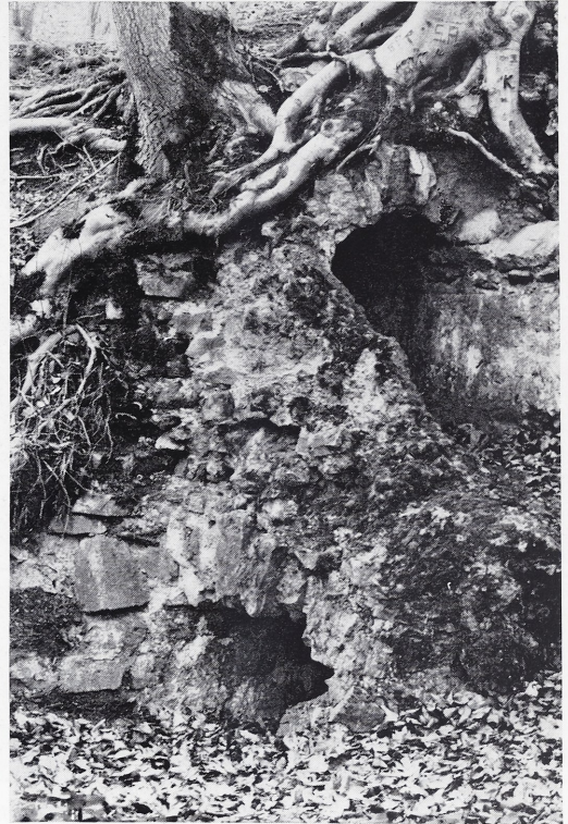
4 Keldenich-Dalbenden, Kreis Schleiden. Unter der Baumwurzel die römische Wasserleitung, darunter der rechtwinklig unter der Leitung hergeführte Durchlaß für die vom Berg abfließenden Tageswässer.
