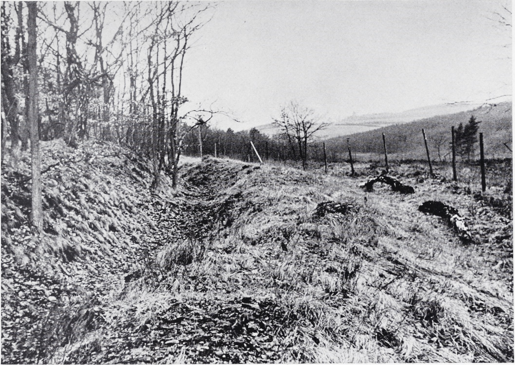
1 Die römische Wasserleitung für Köln etwa 400 m südlich der Katzensteine. Das Mauerwerk der Leitung ist im Mittelalter zur Steingewinnung ausgebrochen worden. Der Graben gibt diese Ausbruchgrube, der Wall rechts daneben den beim Ausbruch angefallenen Schutt an.
