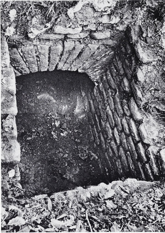
3 Breitenbenden, Kreis Schleiden. Einstiegsschacht der römischen Wasserleitung westlich der 'Quelle' (siehe Plan Abb. 18).
