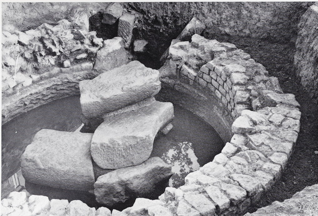
31 Im Hintergrund der beschädigte Auslauf nach Köln. Im Inneren die Zinnensteine im Zustand der Auffindung. Blick von Südwesten.
