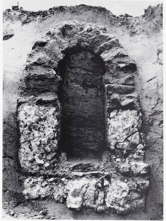
12 Querschnitt durch die frühe, unterirdisch verlegte Leitung (siehe Plan Abb. 9 Punkt 3). Die U-förmige Rinne aus hartem Stampfbeton (hell) und das über ein Lehrgerüst gemauerte Gewölbe (dunkel). Die lichte Höhe beträgt 1,40 m.
