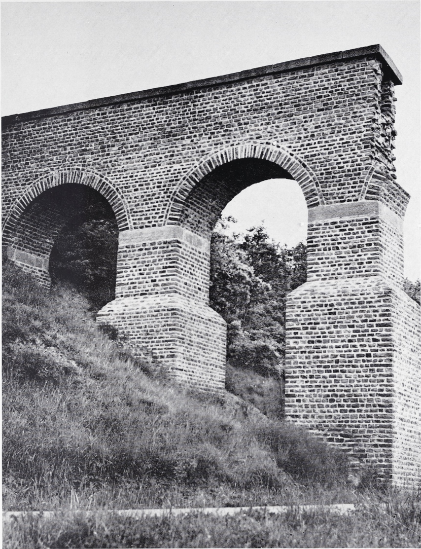
27 Vussem, Kreis Schleiden. Das wiederaufgebaute Stück des römischen Aquäduktes auf den Pfeilern 12–14, von Norden gesehen.
