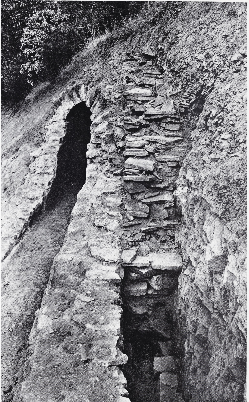
8 Weyer-Eiserfey, Kreis Schleiden. Querschnitt durch die intakte Wasserleitung (links) und das Trockenfutter über der kleinen Dränage- leitung (rechts). Der Hang steigt steil nach rechts an (siehe Punkt 3 der Übersichtskarte 1 : 100 000 auf Abb. 18).
