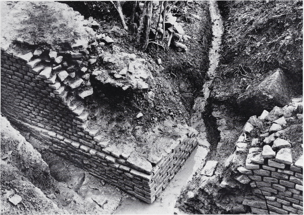
5 Breitenbenden, Kreis Schleiden Durchlaß für einen Quellbach unter der römischen Wasserleitung; Grabungsbefund im Krebsbachtal (siehe Plan Abb. 17).
