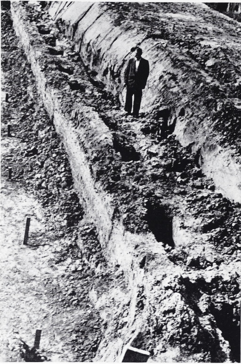
11 Die beim Autobahnbau nördlich von Efferen zerstörte Wasserleitung. Die Rinne gehört der älteren, unterirdisch verlegten Leitung an. Darin sind die Pfeilerstandorte der späteren, höher gelegenen Leitung als Trümmerhaufen sichtbar (siehe Plan Abb. 9 Punkt 1).
