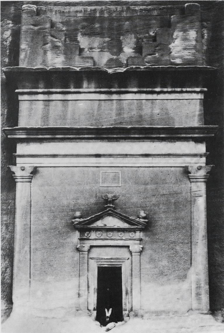
27 Hegra, Fassade B 6.
