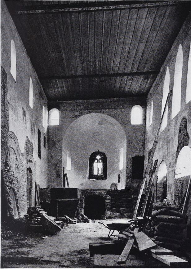
9 Das Mittelschiff während des Wiederaufbaus der Kryptenwand.
