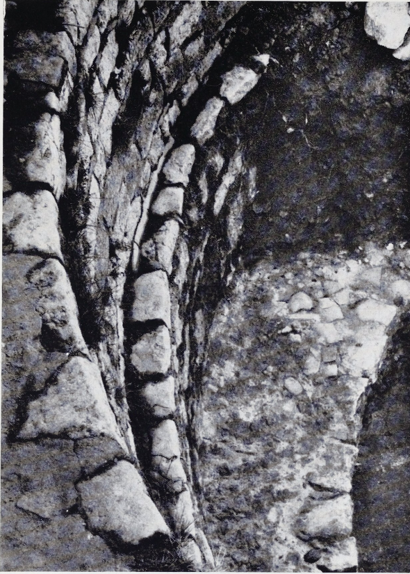
7 Grabung 1964. Chorbau, Apsisfundament Kapellenbau I, Innenseite, darüber Hauptapsisfundament Chorbau II und hochgeführtes Mauerwerk von 1885 III.
