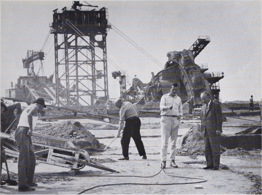
2 Grabungsarbeiten vor dem Bagger.
