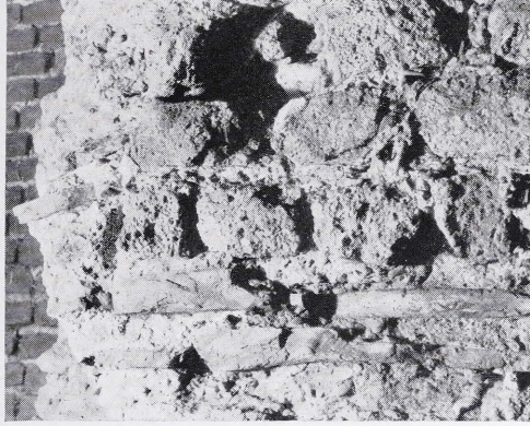
Abb. 2. Südostecke der Südmauer innen. Links mit Resten eines Blendbogens vom Turmeingang.
