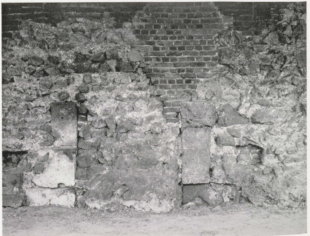
Abb. 2. Südmauer Innenseite. Vermauerter, 1,80 m breiter Mauerdurchlaß.
