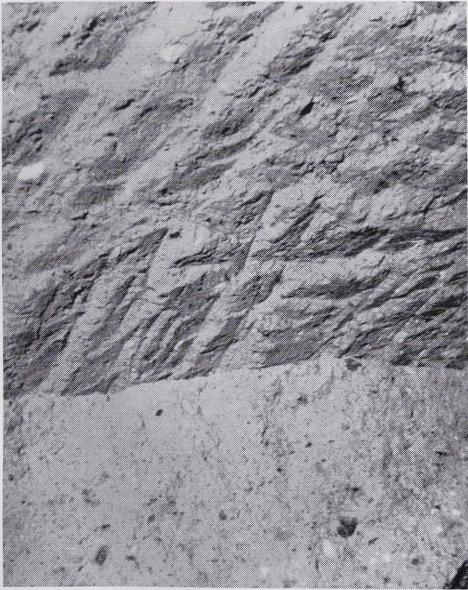
Abb. 3. Beilhiebe im Deckenschrot.
