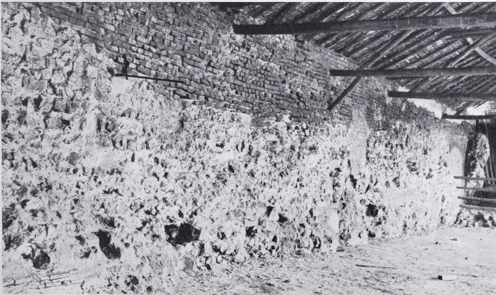
Abb. 2. Haus Bürgel. Die südliche Kastellmauer, Innenseite von Ostnordosten. Im Hintergrund Turmrest, Verblendung überall fehlend. Lagenweise Schichtung des Mauerkerne gut erkennbar, unten Rüstlochreihe. Im Vordergrund links Reste des zweiten Ziegelbandes.
