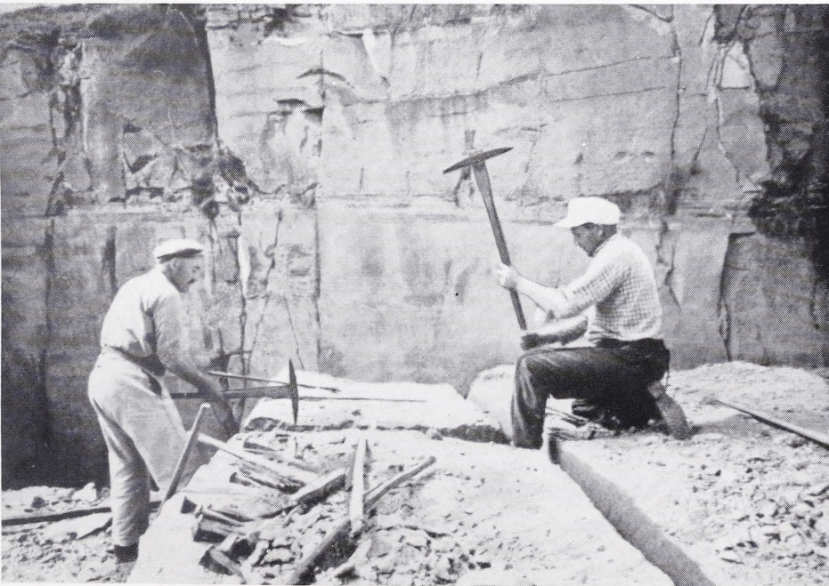
Abb. 2. Ausschlagen eines Schrotgrabens in einem Steinbruch in Weibern.
