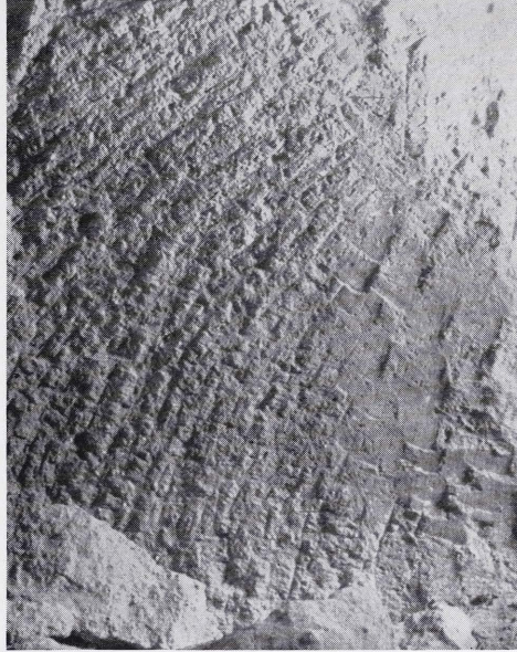
Abb. 2. Beilhacke, Spuren der Beil- (breit) und der Hackenschneide (strichförmig).
