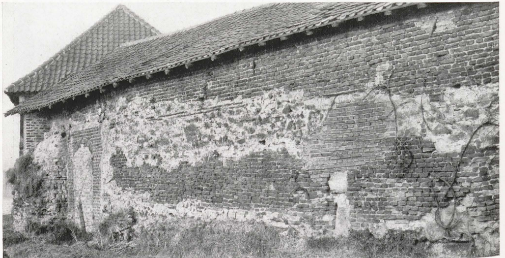
Abb. 2. Haus Bürgel, Südmauer, Außenseite. Vorn vertikale Tuffblöcke eines römischen Durchlasses. Das helle Mauerwerk (außer Torfüllung links) ist römisch. Oben Rest eines doppelten Ziegelbandes. Ganz links römischer Turmrest.
