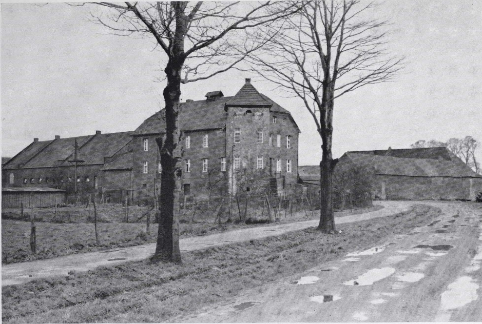
Abb. 1. Haus Bürgel nach Südwest. Zustand 1959.
