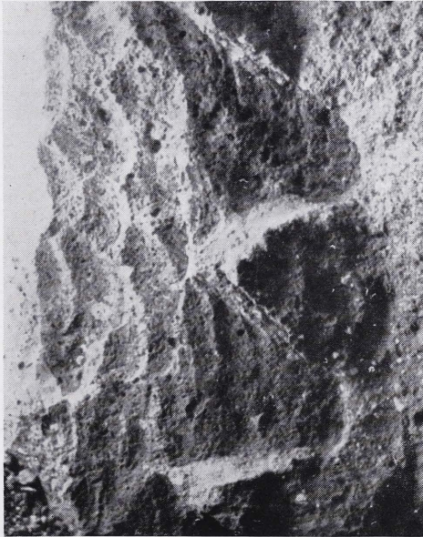
Abb. 4. Keil mit Keiltaschen und Spuren des Schrotbeiles (Beilhacke).
