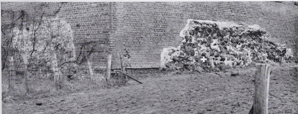
Abb. 4. Südostecke von außen. + Fundstelle des gestempelten Ziegels. Das moderne Mauerwerk sitzt im Hohlraum des römischen Eckturms.
