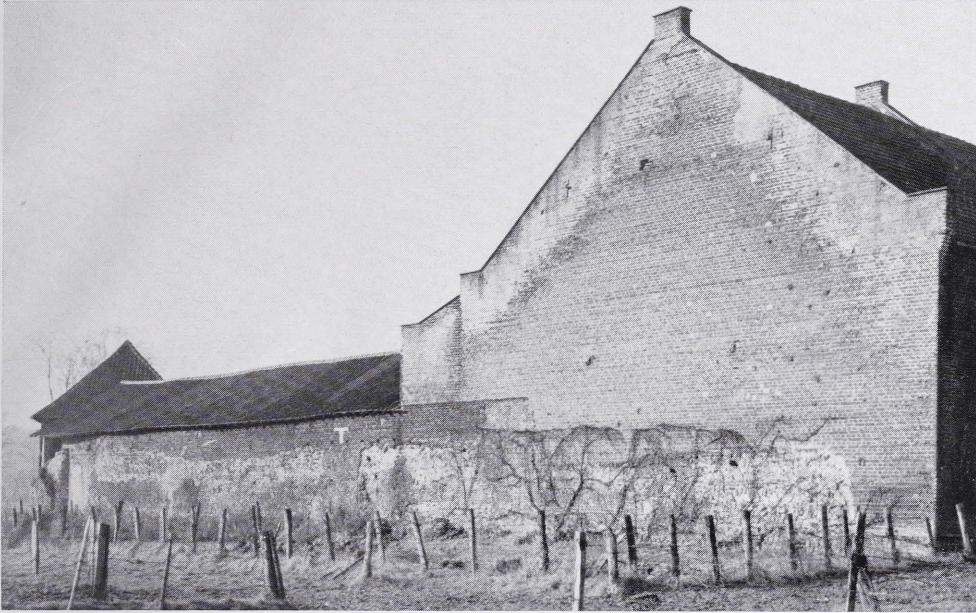
Abb. 1. Haus Bürgel. Die zwei östlichen Drittel der Südfront von außen. Etwa in der Bildmitte bei T moderne Mauerplombe aus Backsteinen, die römische Turmhöhlung ausgleichend.
