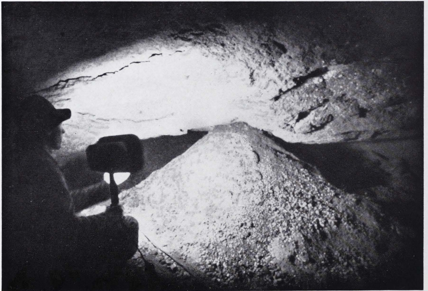
Abb. 3. Erdkegel unter ehemaligem Stollen.
