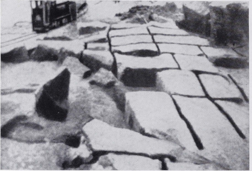
Abb. 1. Römischer Tagebau mit Schrotgräben in Kluft.
