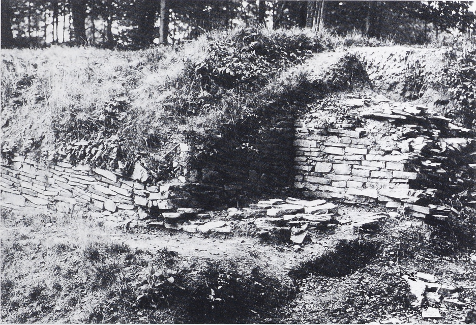
13 Alteburg, Essen-Werden. Sogenannte Flickstelle.
