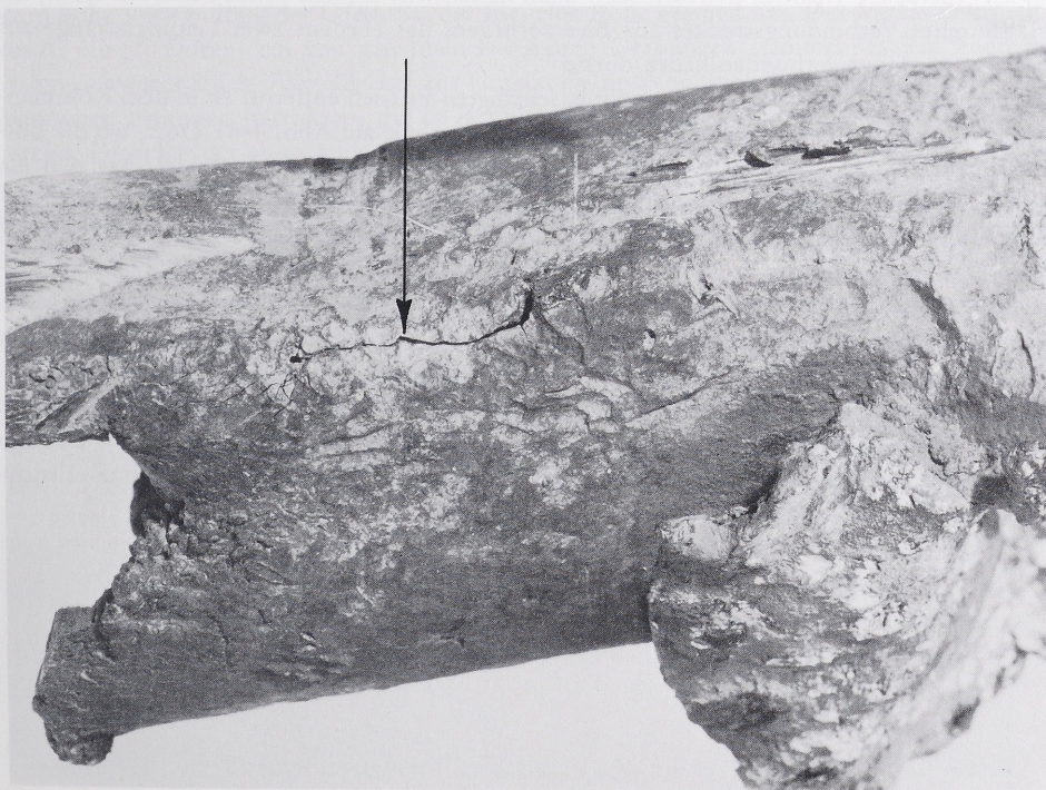
5 Oberembt. Bleirohr mit Riß (siehe Pfeil).
