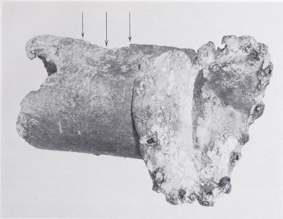
4 Oberembt. Bleirohr mit Flansch, Riß- oder Bruchstelle (siehe Pfeile).
