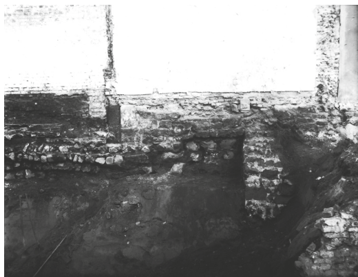
Abb. 6 (oben) Fundament der südöstlichen Außenmauer des Vogthauses mit abzweigender Mauer und zugesetzter Türöffnung. – Abb. 7 (unten) Ansicht der Mauer Bo/1963-157.
