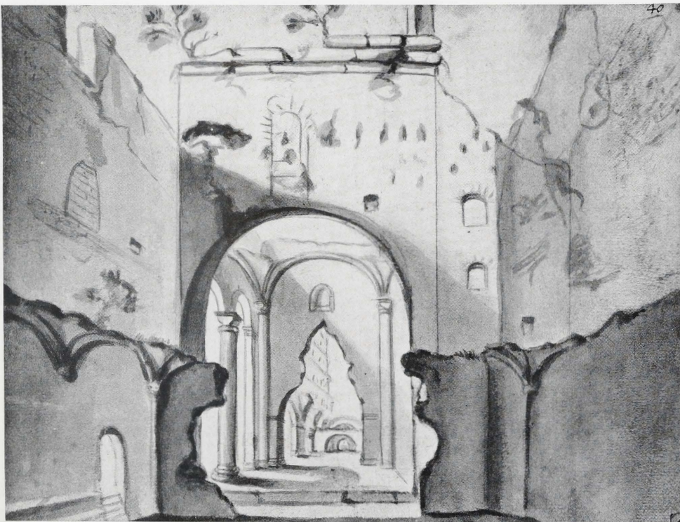
Abb. 2. Hocheltten. Blick aus dem zerstörten Sakristei(?)anbau zwischen Chor und Nordflügelruine in diese und das zerstörte Nordseitenschiff nach Westen um 1670, Blatt 40.
