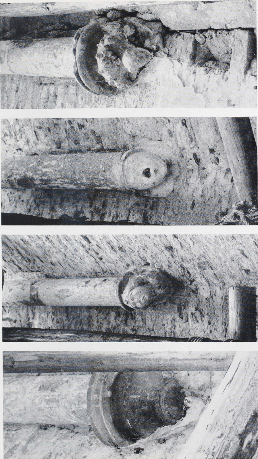
Abb. 1—4. Hochellen. Im Chorschluß wieder eingebaute gotische Dienskonsolen.
