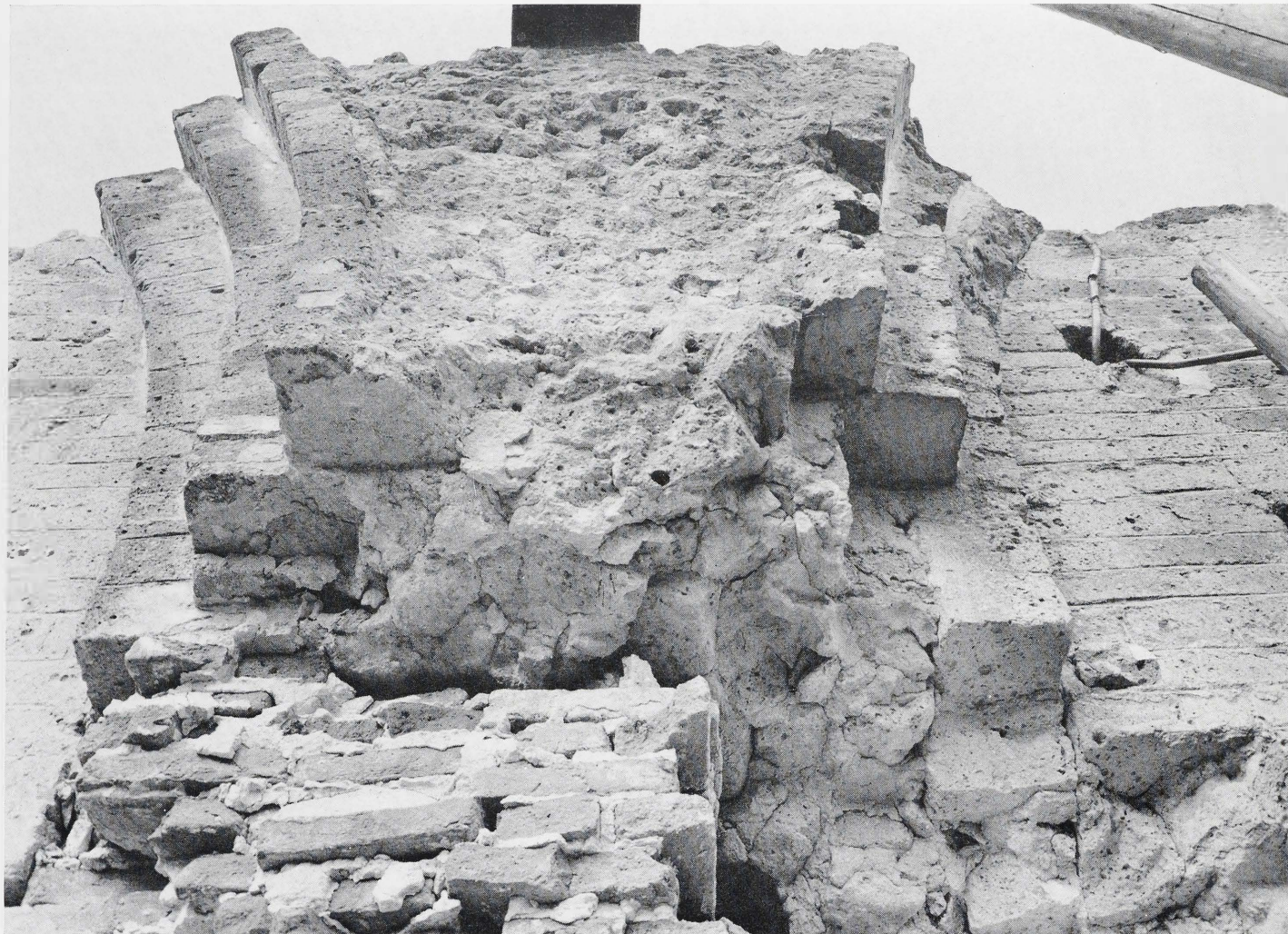
Hochelten. Gewölbezwickel zwischen dem 3. Joch von Westen und Chor in der Nordwand des Mittelschiffes am 5. Oktober 1956.
