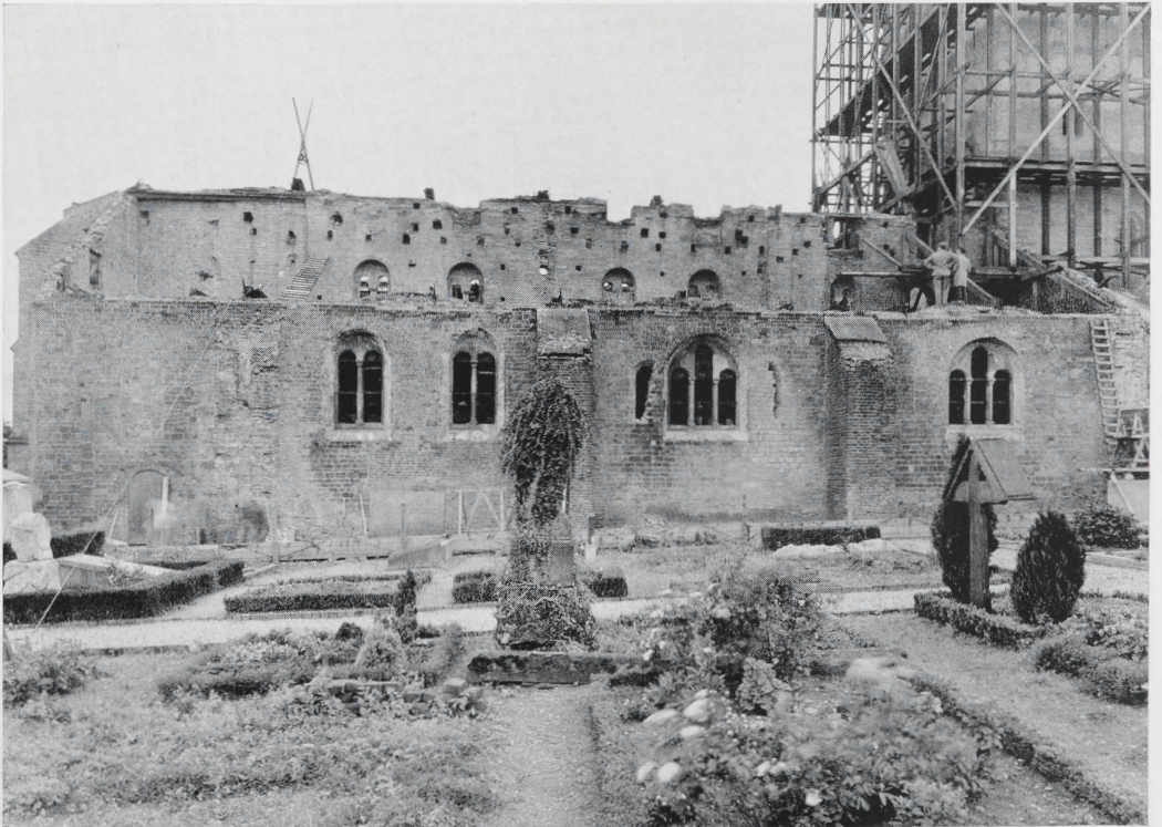
Abb. 2. Hochelten. Nordseitenschiff und Hochgadenwand nach Süden am 5. November 1956.
