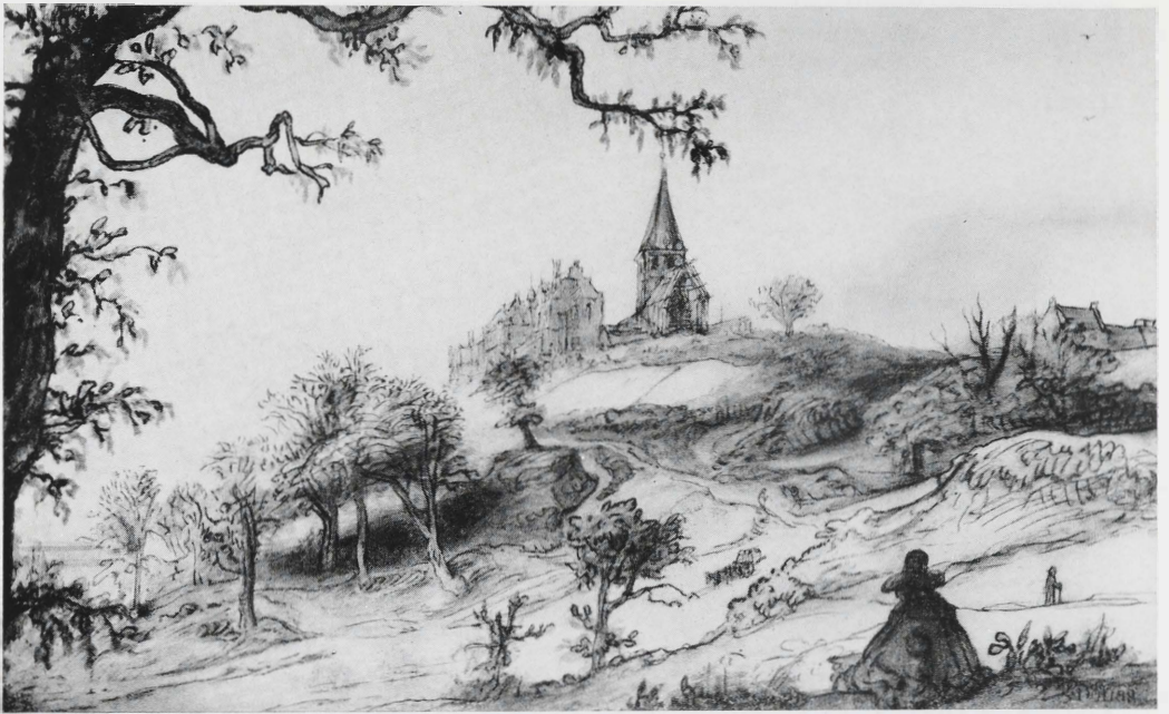
Abb. 1. Das Hochellener Stift mit den teilweise wieder aufgebauten Stiftsgebäuden und der Stiftskirche im Wiederaufbau zwischen 1670 und 1677, aquarellierte Federzeichnung von Lambert Doomers (1622/23–1700).
