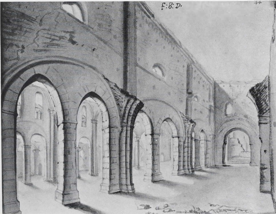
Abb. 2. Hochelten. Die drei Ostjoche des zerstörten, gotischen Südseitenschiffes nach Nordost mit Blick in das Mittelschiff, Nordseitenschiff und Seitenquerflügel um 1670, Blatt 44.
