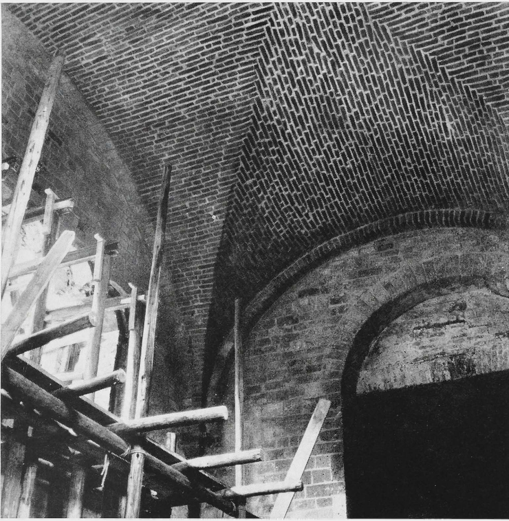
Abb. 1. Hochelten. Nordseitenschiff, Südwestecke.
