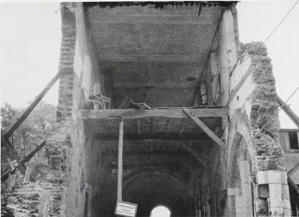
Abb. 1. Xanten. Der zur Hälfte zerstörte Westflügel des Kreuzganges nach Norden am 12. September 1952.
