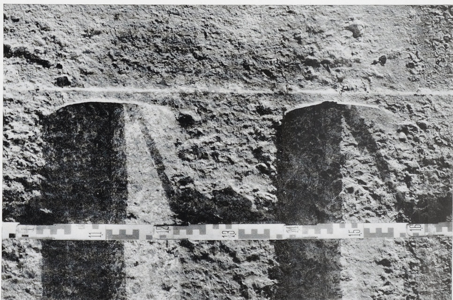
16 Triglyph des Ringhallenfrieses, oberer Abschluß der Triglyphenkerben (Bogenform steht im Gegensatz zu Bild 15 b).
