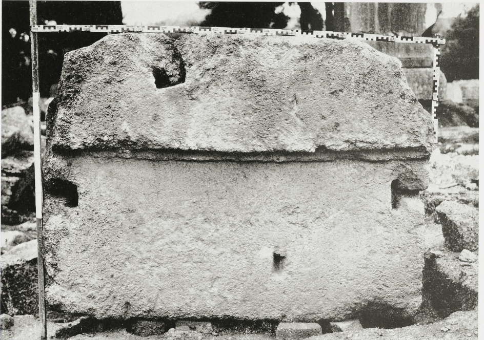
18 Block der Gruppe 'AS' vom Ostgiebel (vgl. Bild 17), Oberseite. Das Stück ist eine umgearbeitete Säulentrommel einer ehemaligen Frontsäule des Tempels; links und rechts oben Kannelurenreste.
