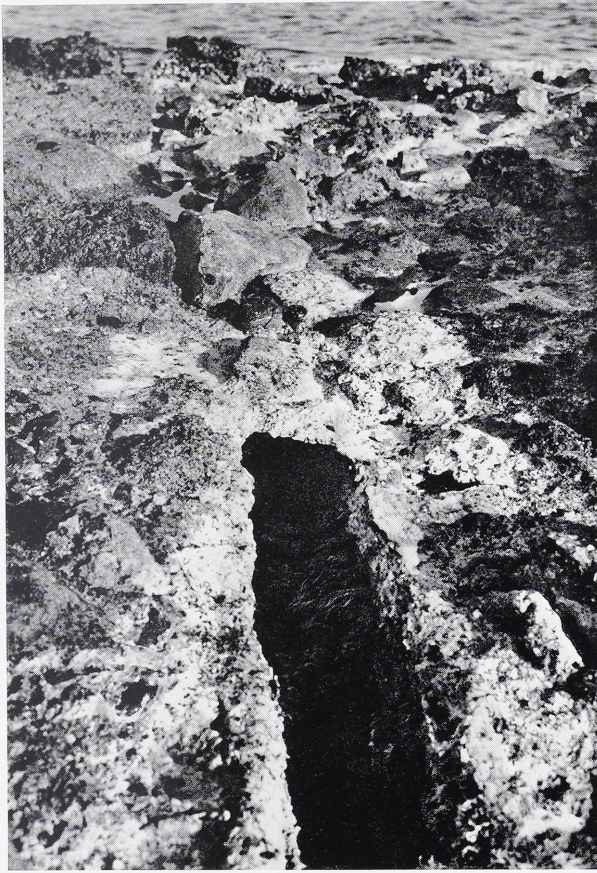
6 Rinne im Beton der Nordost-Mole des Hafens von Side (1967). Im Mittelgrund deutlich der Mörtelrest zu sehen, der über die Holzzange floß, als auf dem Beton-Unterbau das Quadermauerwerk errichtet wurde, das jetzt verlorengegangen ist.
