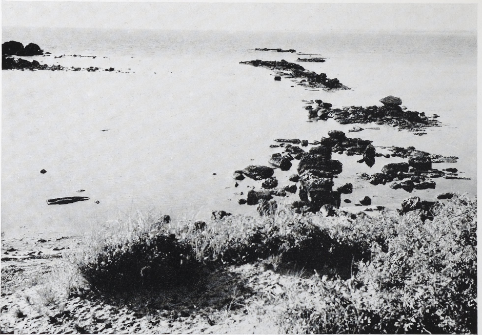
4 Die Nordost-Mole des Nordhafens von Side (1967). Blick vom Festland in Nordwest-Richtung.
