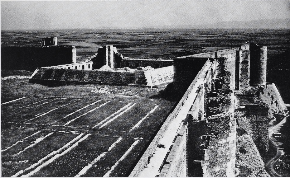
6 Lucera, Blick auf die Ringmauer und das Palastkastell Kaiser Friedrichs II.
