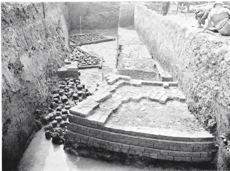
4 Chorfundament mit Pfahlrost von Osten.
