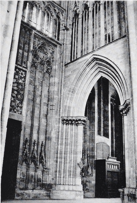
18 Straßburg, Münster. Westbau-Inneres, Mittelschiff und Nordturm-Erdgeschoß.
