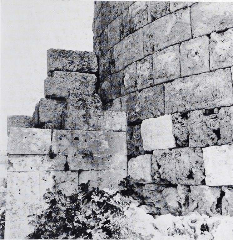
2 Perge, hellenistischer Ostturm der Anlage Bild 1 mit angeschobenem römischem Außentor.
