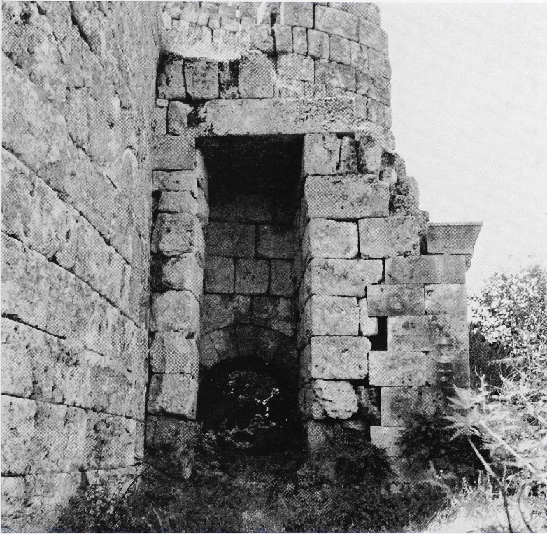
4 Perge, Südtor. Westliche Außenwand (Rückseite von Bild 3) mit hellenistischem Wehrgang.
